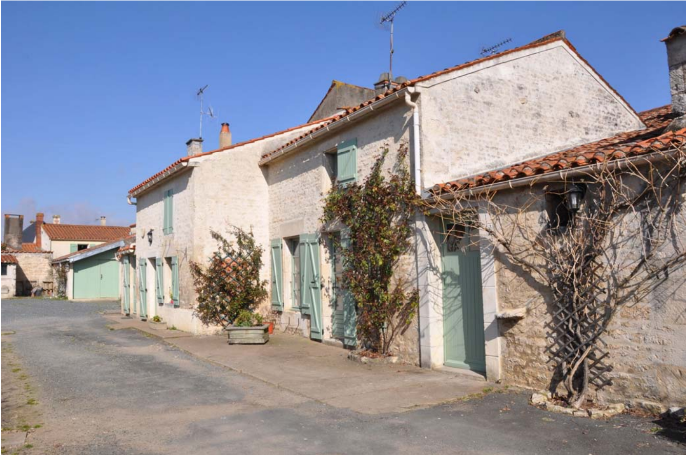
UP49-20-26A Maisons de bourg mitoyennes à l'alignement des rues ou de venelles (Nalliers)
