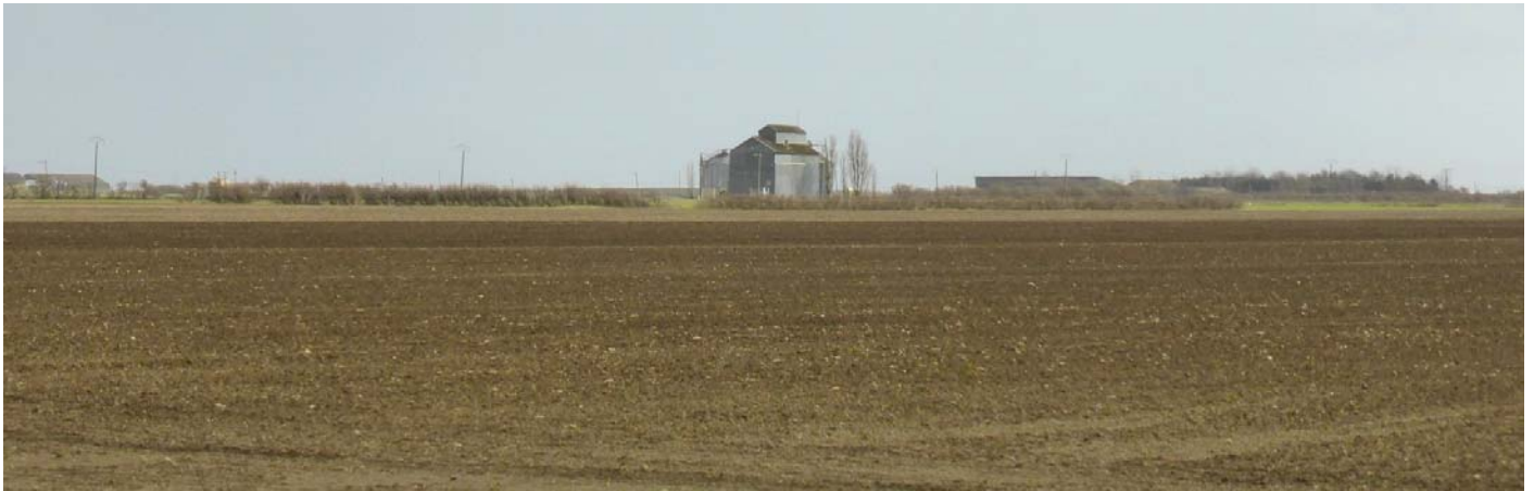
UP49-40-08 L'aspect volumineux du bâti agricole est accentué par le caractère ouvert du paysage (Champagné-les-Marais – 2015)
