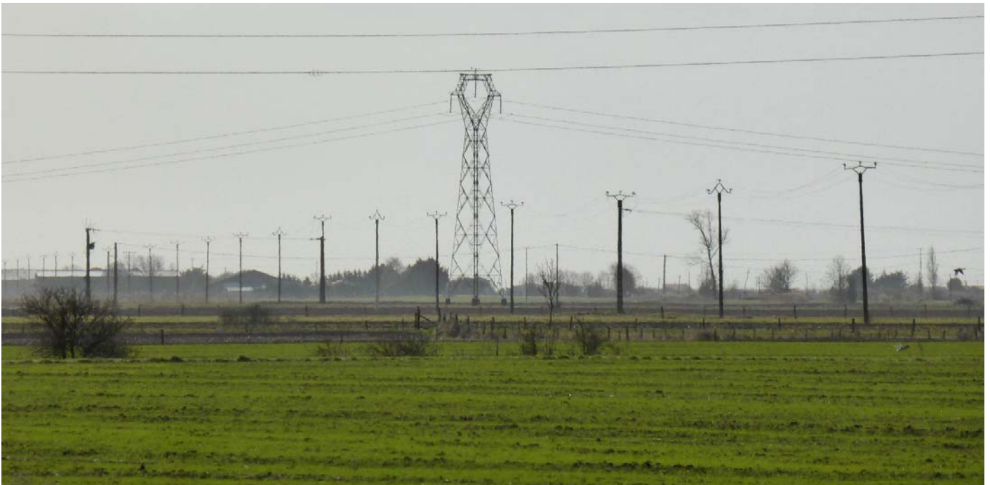
UP49-40-10 Le caractère horizontal du paysage amplifie la visibilité des installations électriques (Champagné-les-Marais – 2015)
