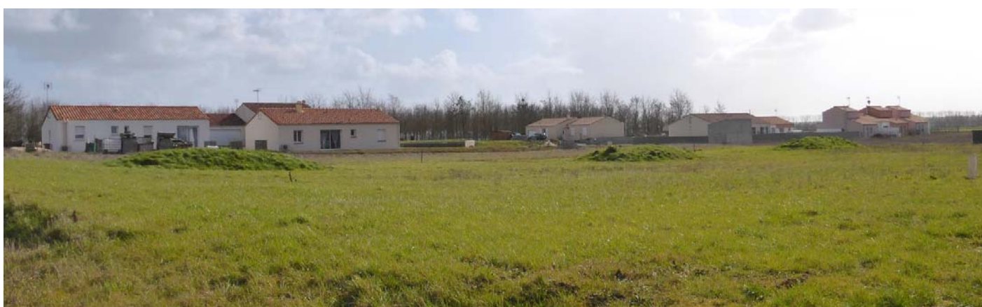
UP49-40-06 Les constructions récentes sont particulièrement exposées en situation de frange urbaine (Vouillé-les-Marais - 2015)
