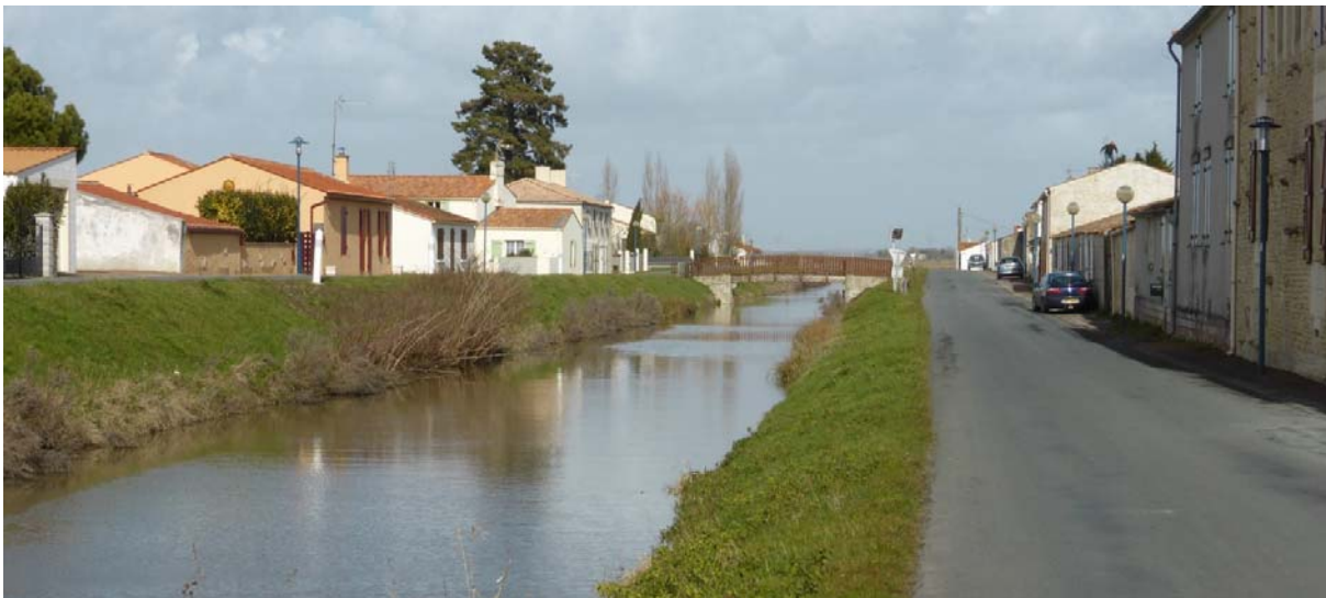
UP49-50-01 Privilégier comme ici un enherbement simple de la berge qui donne une unité d'aménagement entre le marais et l'espace urbanisé (Champagné-les-Marais)
