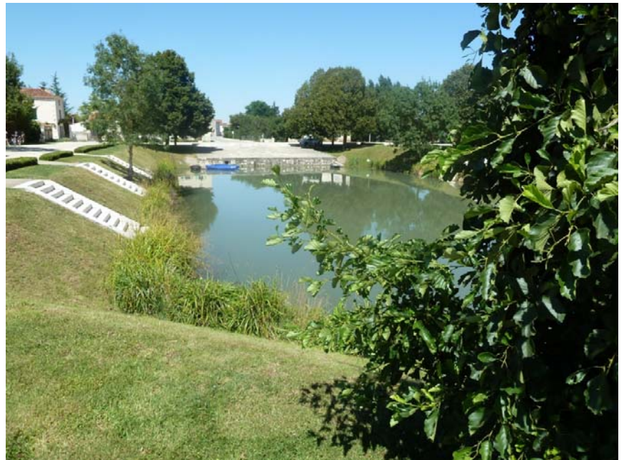
UP49-30-10 Port réaménagé de Courdault (Bouillé-Courdault- source PNR Marais Poitevin)
