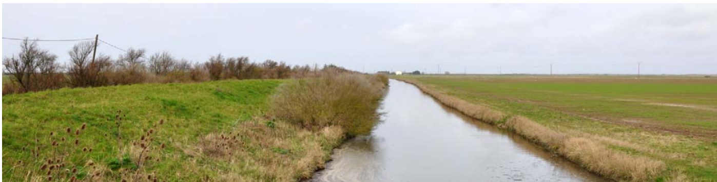
UP49-20-13 Digue (bôt) et fossé (contre-bôt) protégeant des crues le marais desséché (Champagné-les-Marais)
