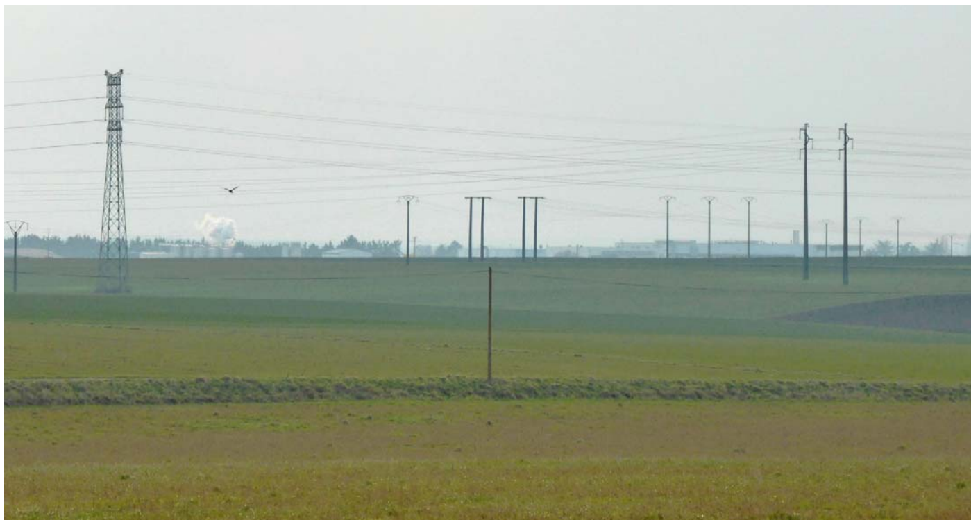
UP48-40-09 Vue vers le sud depuis la D745 (sortie est de Fontanay-le-Comte) : Les infrastructures liées au transport de l'électricité sont très visibles dans le cadre des paysages de champs ouverts
