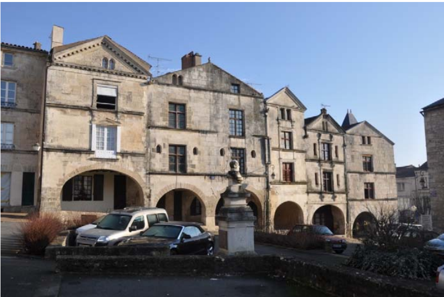
UP48-20-15 Des ambiances urbaines marquées par une architecture renaissance remarquable (Fontenay-le-Comte)
