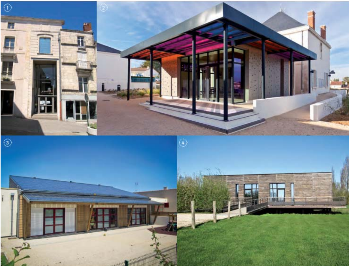
1 : Médiathèque Jim-Dandurand, réhabilitation, architecte : Bruno Donzet, 2003, Fontenay-le-Comte. / 2 : Mairie de Sérigné, réhabilitation et extension, architecte : Cabinet Groleau-Pochon, 2012 / 3 : Centre intergénérationnel, architectes : Agence Boisson-Burban, 2009, Mouzeuil-Saint-Martin 4 : Accueil de la Réserve biologique départementale de Nalliers-Mouzeuil-Saint-Martin, conception : Conseil Général de la Vendée, 2005, Nalliers-Mouzeuil-Saint-Martin.
