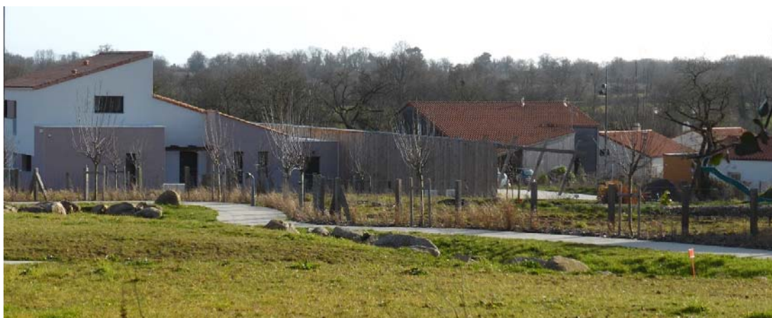
UP47-50-09 Le cadre des opérations d'ensemble de type écoquartiers permet de mener une réflexion sur la relation paysagère entre l'urbain et le rural (Ecoquartier de la Marronnière à Le Bourg-sous-la-Roche – 2015)
