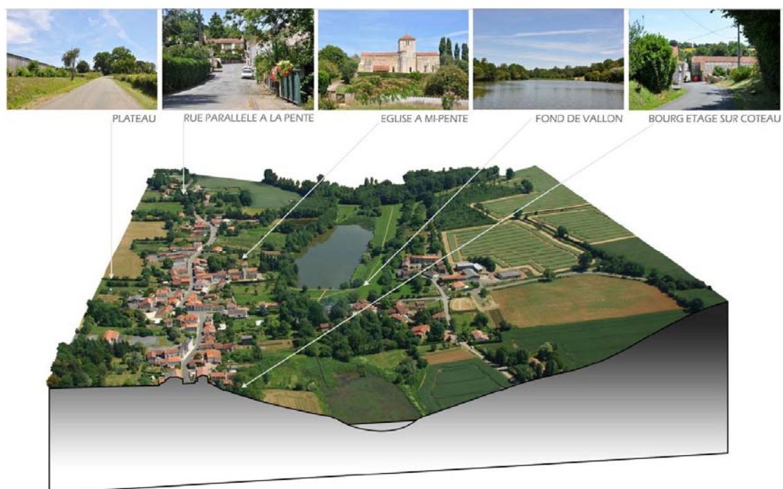
UP46-20-16bis Principe d'étagement du bourg sur le coteau (Marsais-Sainte-Radegonde – Source CAUE 85)
