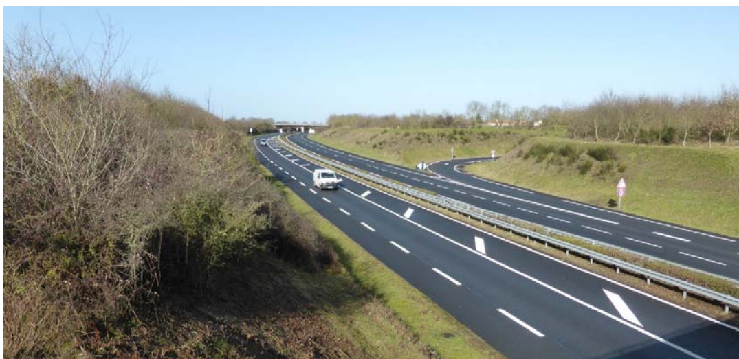
UP46-40-01 Le contournement du centre ancien sous forme de 2x2 voies accentue l’inscription des infrastructures routières dans le paysage. Les talus végétalisés forment un écran entre la route et l’espace urbanisé (Bournezeau - 2015)
