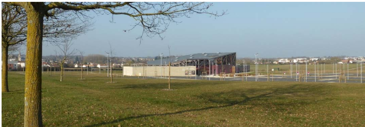
UP45-40-02 Les axes de contournement de bourg et les giratoires associés créent de nouveaux lieux stratégiques pour l'implantation des bâtiments d'activités et des équipements publics structurants (Chantonnay – 2015)
