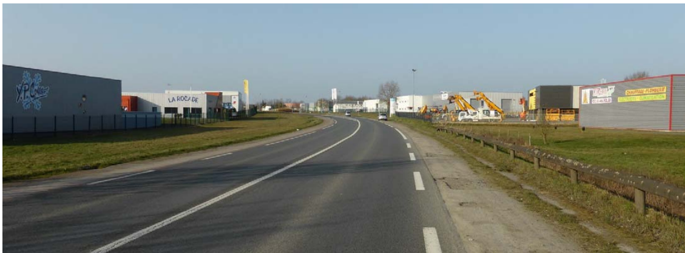
UP45-40-06 Développement des zones d'activités le long d'une voie de contournement (Chantonay - 2015)
