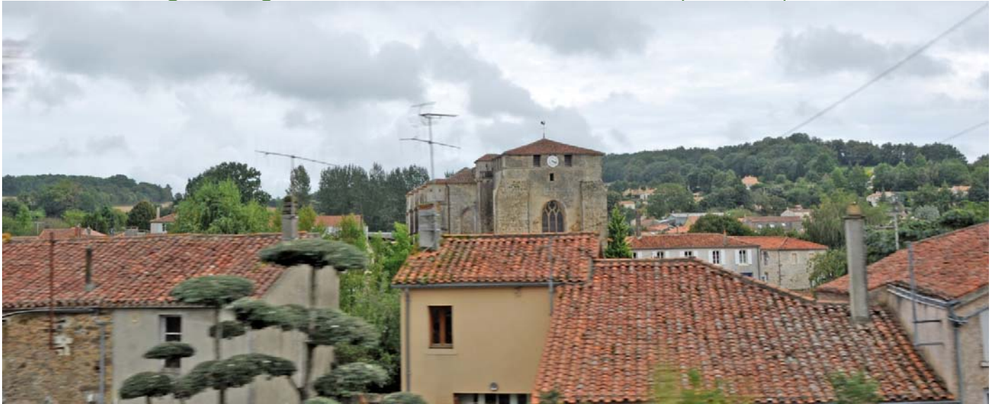
UP45-20-13 Centre bourg dense et étagé de Mouilleron-en-Pareds
