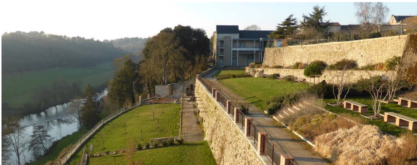
UP44-50-09 Certaines interventions contemporaines fournissent des bons exemples de revalorisation du patrimoine ancien (Mortagne-sur-Sèvre – 2015)
