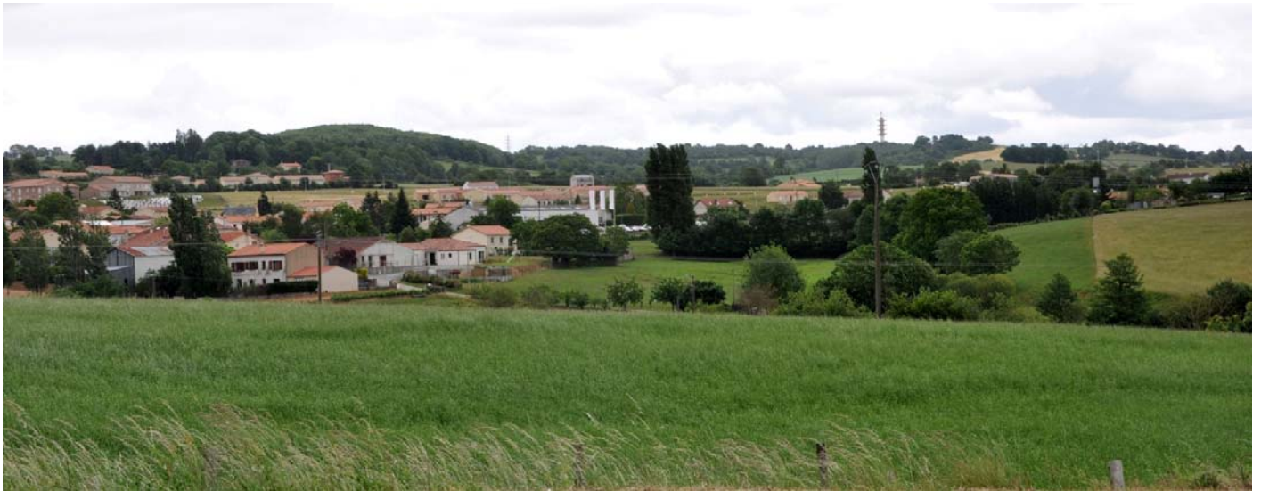
UP44-30-03 Extensions pavillonnaires diffusant dans le bocage (Pouzauges)
