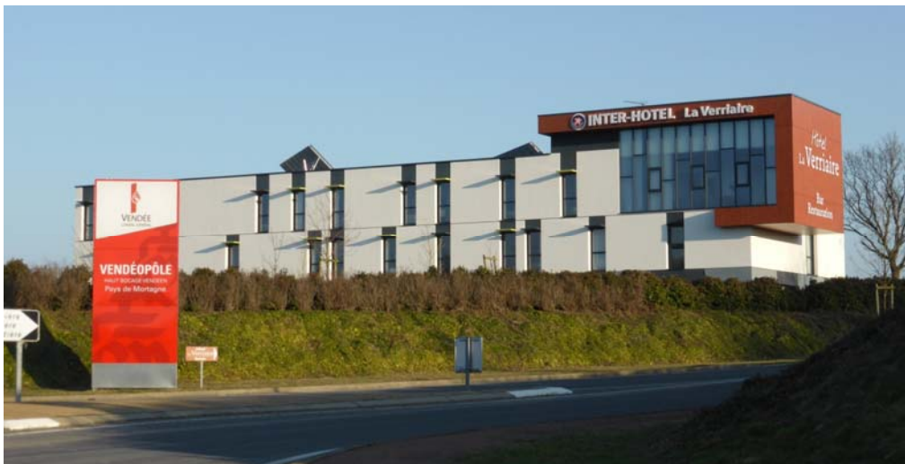
UP44-40-03 Les échangeurs autoroutiers facilitent le développement des zones d'activités sans aucune insertion dans le paysage (La Verrie – 2015)
