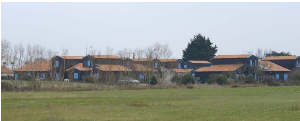
UP43-50-03 Un modèle de formes architecturales nouvelles lié à l'habitat bien intégrées à l'environnement paysager (Beauvoir-sur-Mer)
