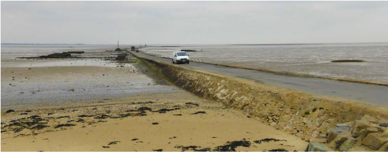
UP43-40-14 Passage du Gois menant à l'île de Noirmoutier : vue depuis le continent (Beauvoir-sur-Mer – 2015)
