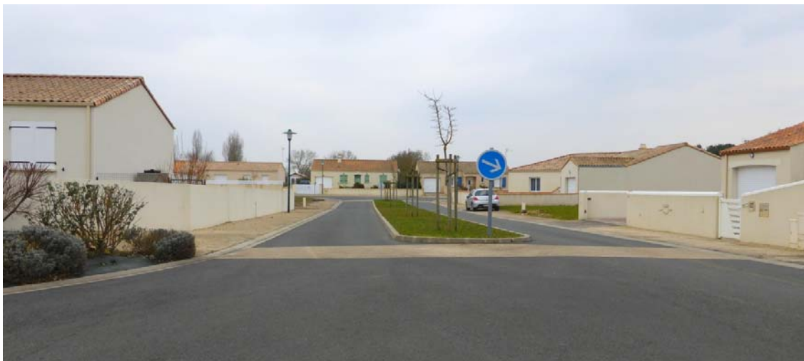
UP43-40-06 Les extensions urbaines prennent la forme d'une diffusion du tissu pavillonnaire (Challans - 2015)
