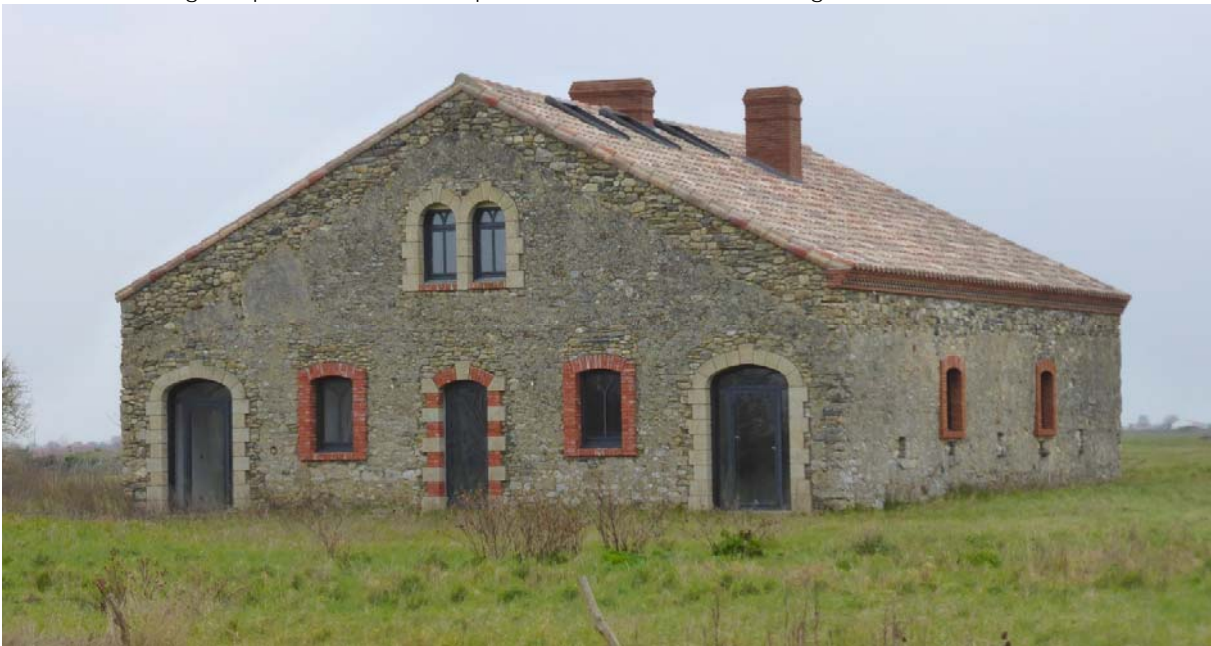
UP43-50-05 Modèle de réhabilitation d'un ancien bâtiment agricole (Beauvoir-sur-Mer)
