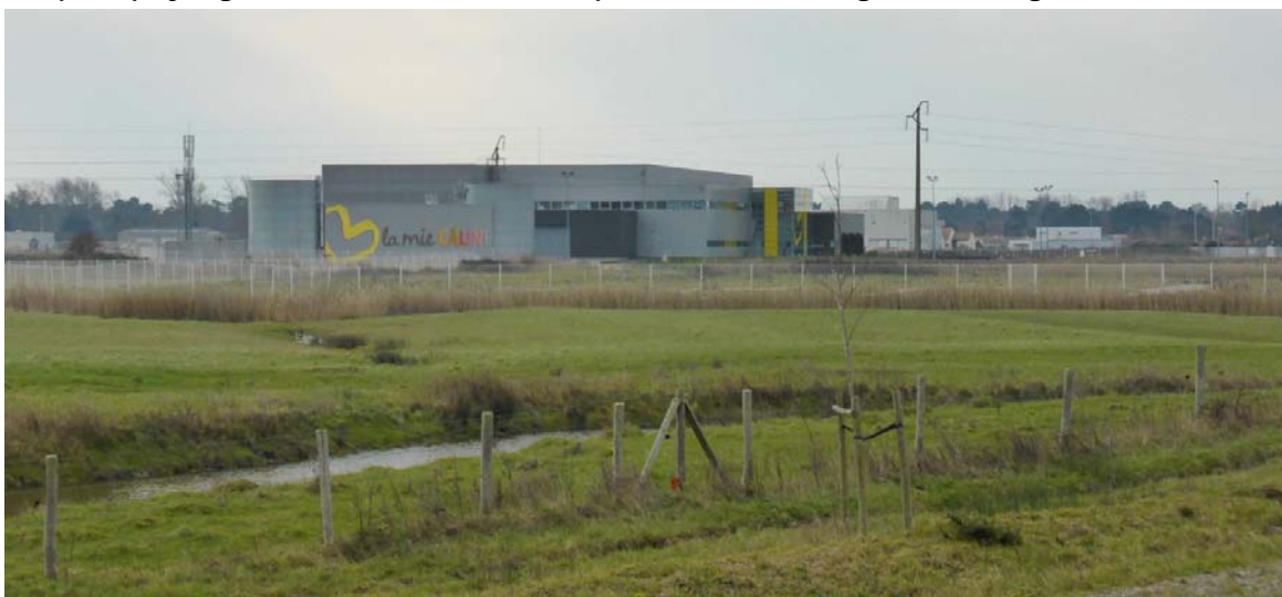
UP43-40-08 Le caractère horizontal du marais amplifie l'exposition visuelle des bâtiments d'activités notamment au niveau des façades tournées vers l'intérieur des communes littorales (Saint-Jean-de-Monts – 2015)
