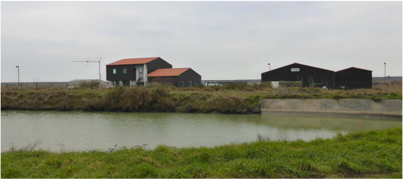
UP43-50-06 Exemple d'intégration de bâtiments d'activités respectueuse de l'environnement paysager (Bouin)
