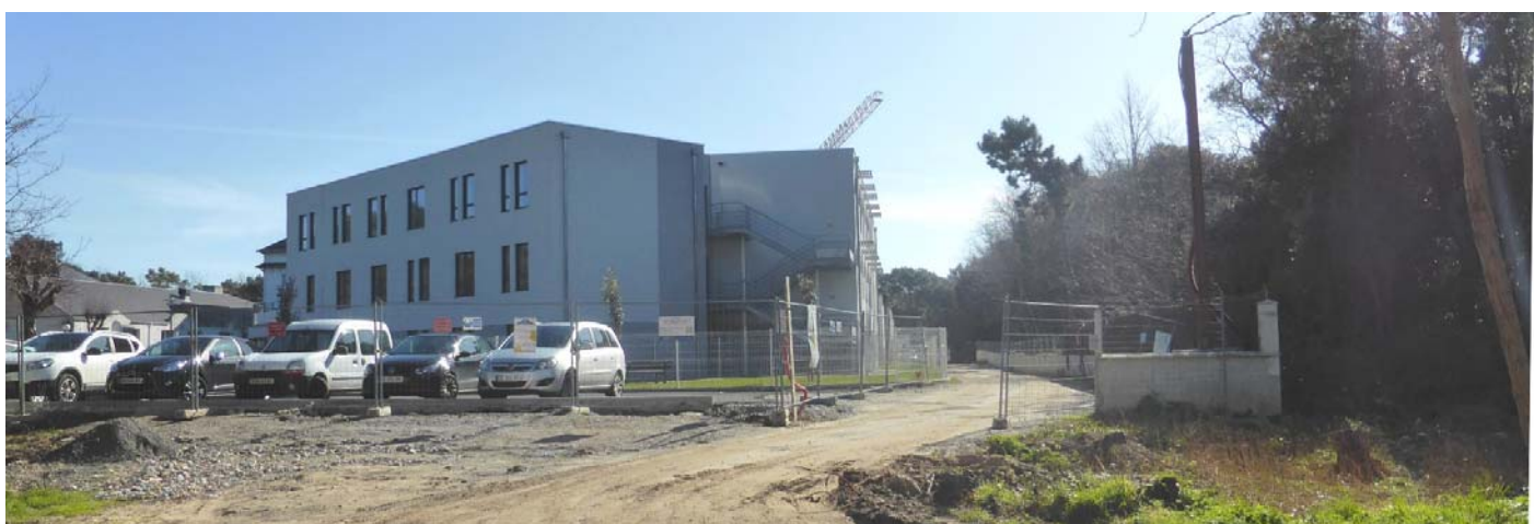
UP42-40-05 Travaux d'extension et de rénovation d'un équipement situé au sein de la forêt domaniale des Pays de Monts (Saint-Jean-de-Monts - 2015)
