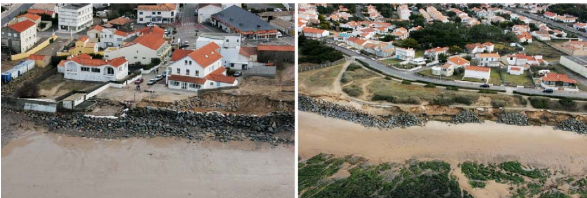
UP42-50-01bis : Un paysage côtier qui se redessine lors d'épisodes climatiques exceptionnel, induisant des risques sur les biens et les populations (Brétignolles-sur-Mer et ouvrages de protection d'urgence après la tempête Xynthia – Source DREAL Pays-de-la-Loire – mars 2010)
