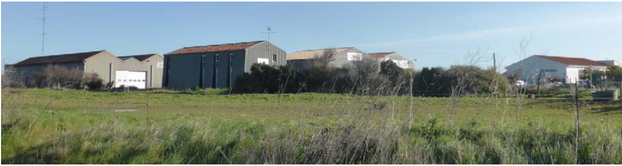
UP42-50-06 Des constructions en lien avec les traditions architecturales locales, notamment en termes colorimétriques, et un affichage publicitaire mesuré facilite l'intégration paysagère des bâtiments les plus imposants (Noirmoutier-en-l'Île)
