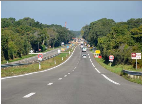
5- Des axes structurants adaptés aux flux touristiques massifs moteurs de l'économie locale, RD213 traversant l'Ermitage (Saint-Brévin-les-Pins)
