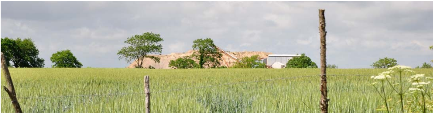
UP40-20-25 Des carrières qui se distinguent plus par leur stock de matériaux et les infrastructures que par leur gisement d'exploitation (Chauvé)
