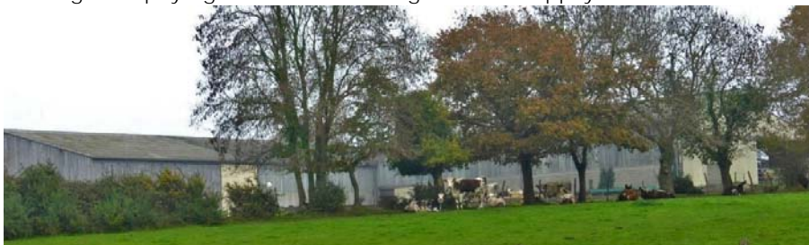
UP40-50-04 Bardage bois et implantation à l'arrière d'un bocage favorisent une bonne intégration paysagère des constructions agricoles (Frossay)
