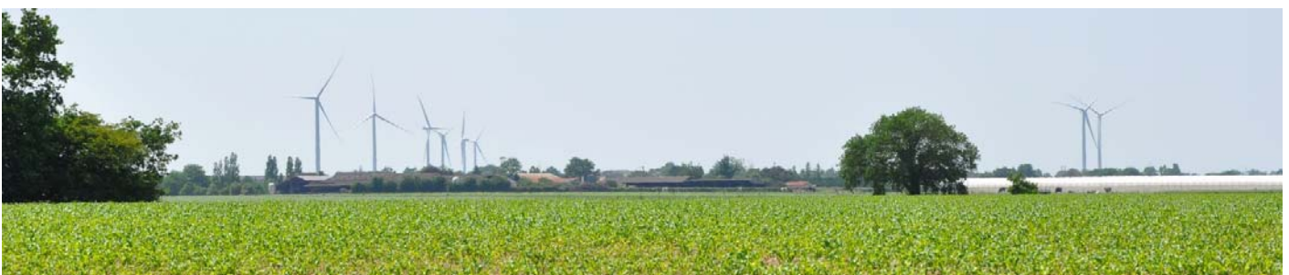
UP39-20-16 Un parc éolien qui marque l'horizon sud de l'unité (La Planche)
