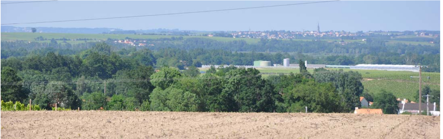
UP38-40-03 La visibilité des bâtiments agricoles sur les crêtes produit de nouvelles silhouettes paysagères. (La Haie-Fouassière)
