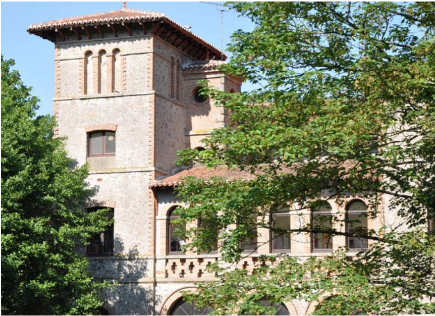
UP38-20-08 Rappelant l'utilisation de la force hydraulique de la Sèvre, un patrimoine architectural industriel jalonne le cours de la rivière, Moulin de Plessard (Cugand)
