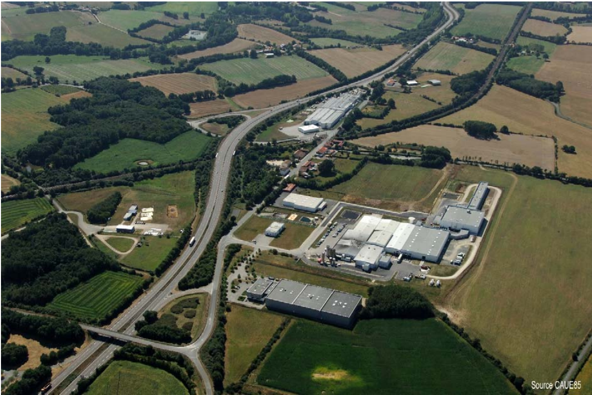
37-50-10 Une gestion des délaissés routiers et ferroviaires par le végétal (Saint-Denis-la-Chevasse – Source CAUE85)
