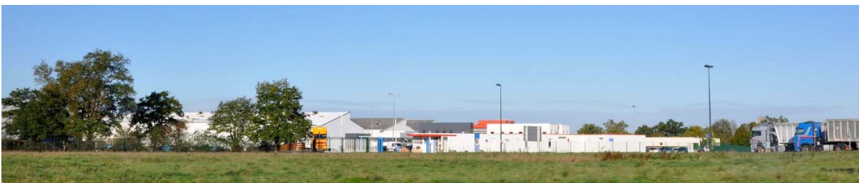
37-20-25 Une ceinture industrielle qui marque la lisière de bourg de la Bruffière
