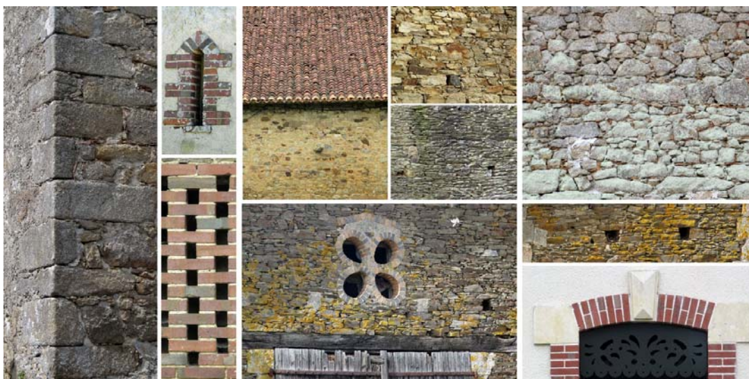
3720-19 Des matériaux de construction traditionnels aux couleurs chaudes (schistes, granits, gneiss, tuile et brique)
