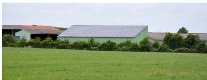
UP37-40-05 Un hangar monumental à toiture solaire monopente qui se distingue dans le bocage
