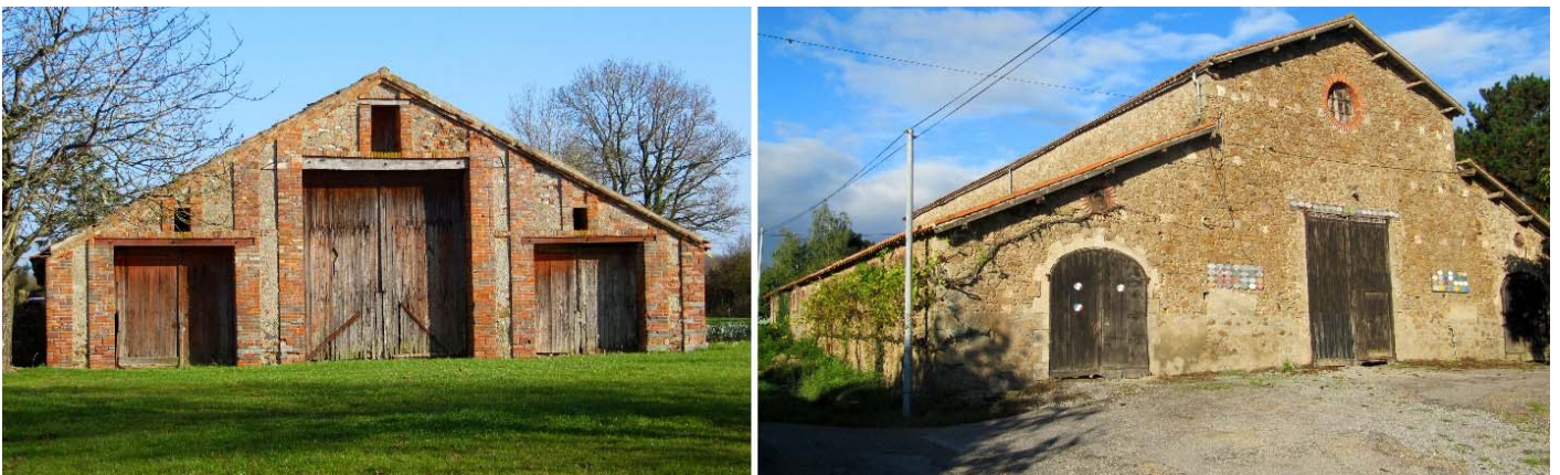
UP37-20-29 Grange simple et grange à nef typique des bocages vendéens et maugeois
