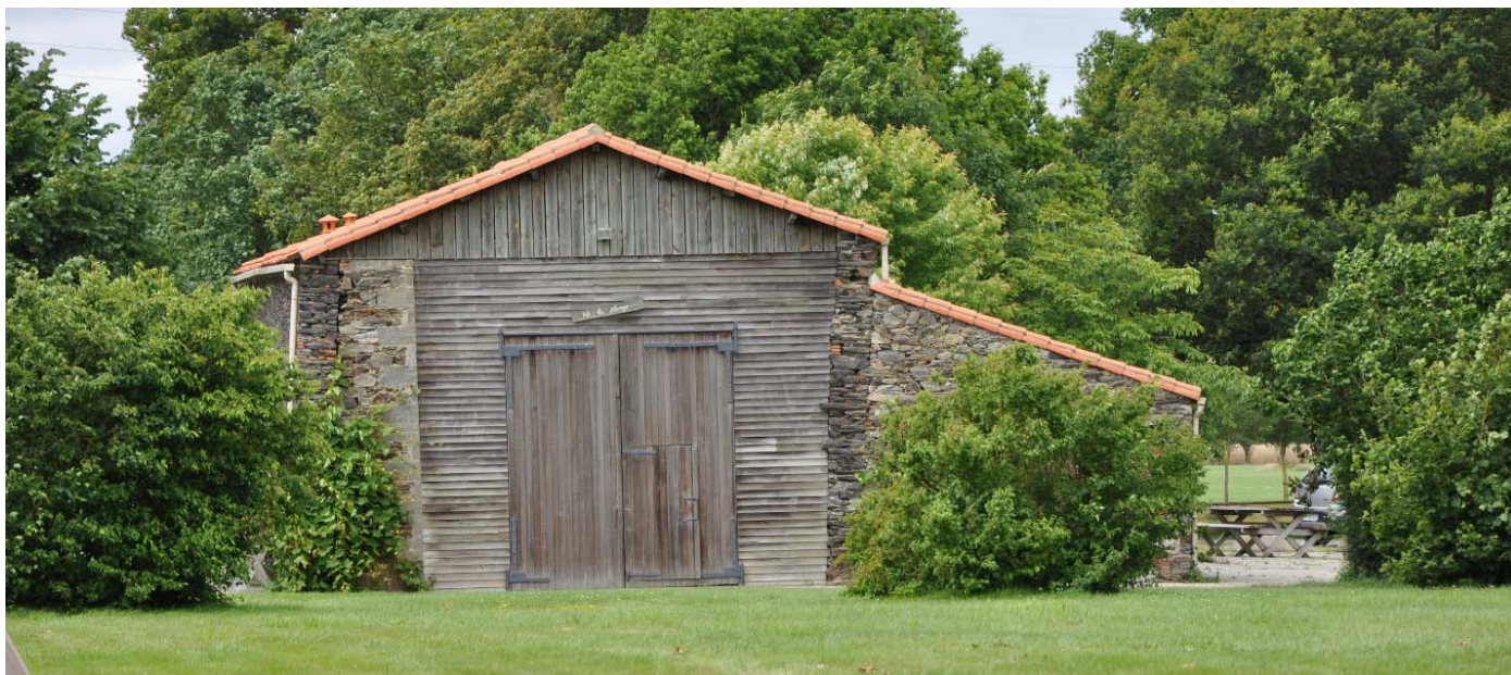
UP37-50-03 Réhabilitation réussie de grange traditionnelle
