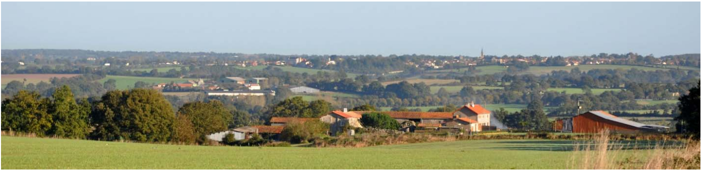
UP37-20-18 Des implantations bâties qui créent des repères dans le paysage et animent les vues (Saint-Martin-des-Tilleuls)
