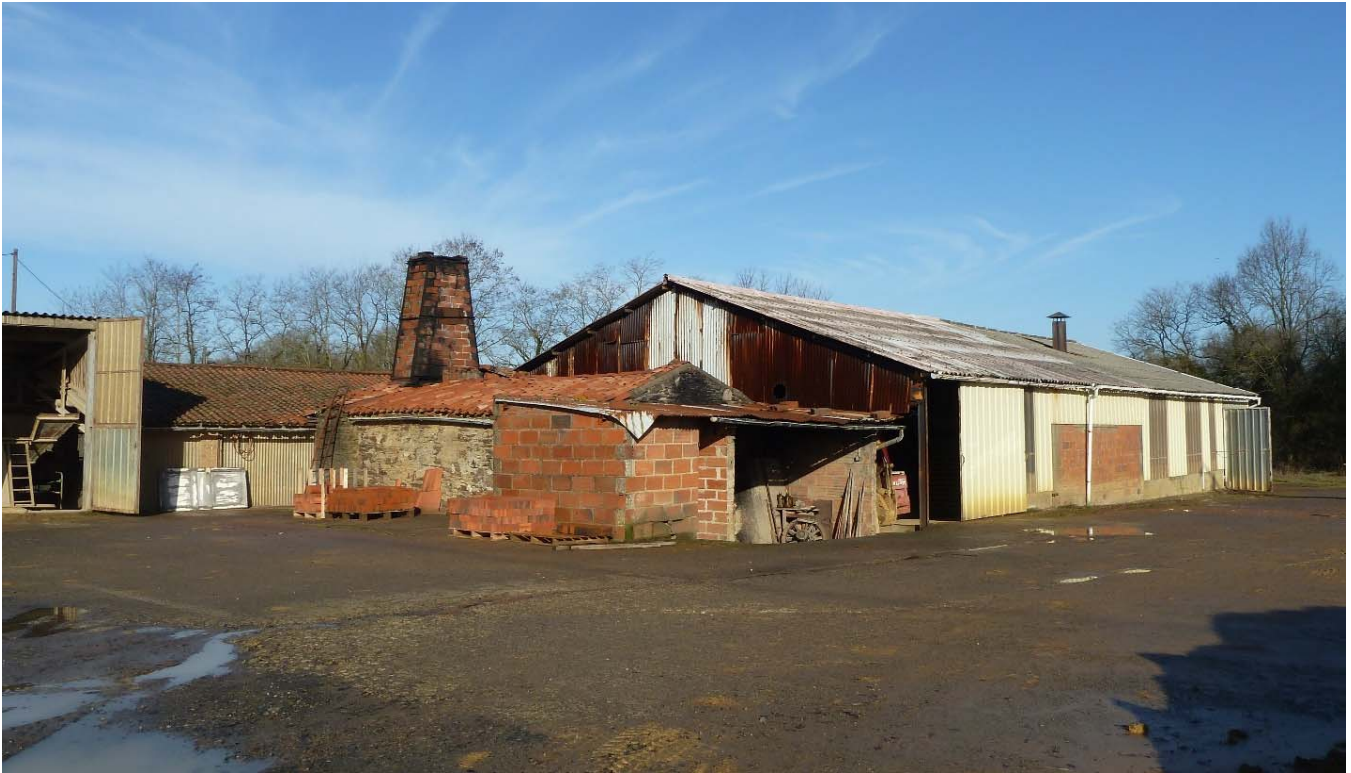
UP37-20-35 Four de briqueterie à Tillières
