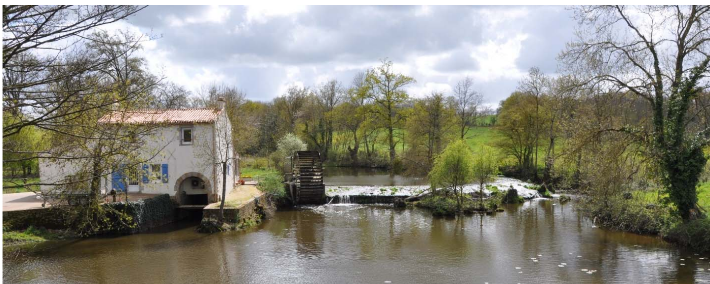
UP37-50-05 Moulin réhabilité aux Lucs-sur-Boulogne
