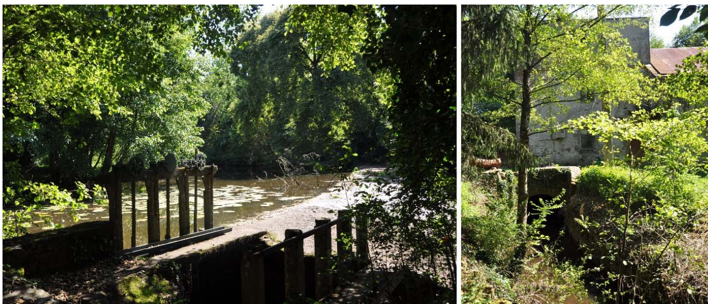
UP37-20-06 Chaussée et moulin à eau dans la vallée de la Grande Maine (La-Boissière-de-Montaigu)
