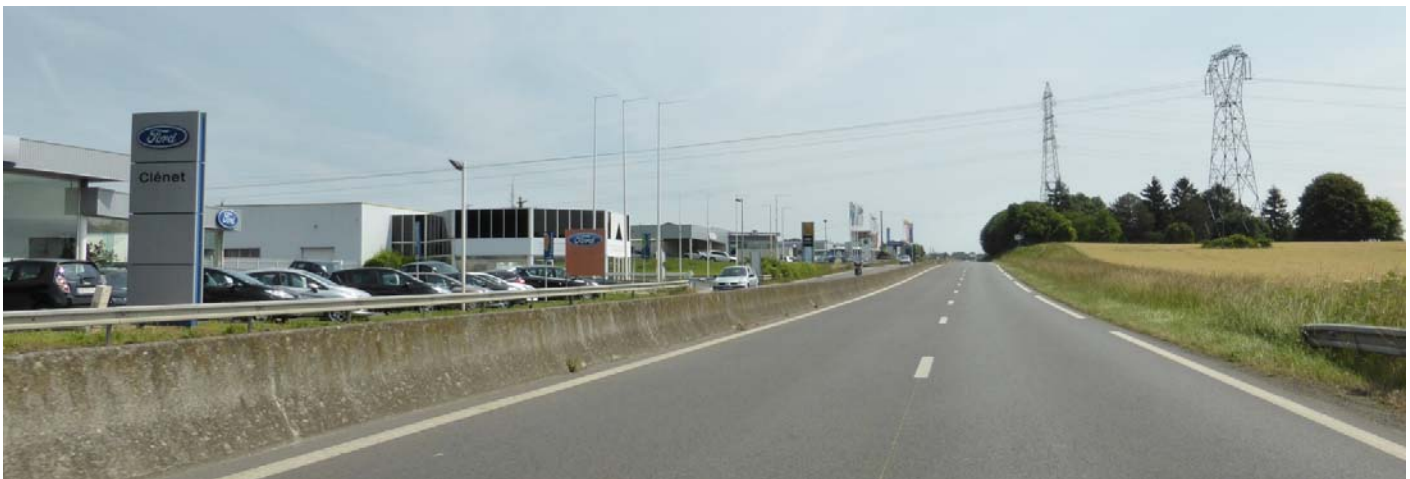
UP35-40-XXX L'entrée ouest de Saumur aux abords de la D960 connaît un développement des activités économiques soutenu (Montreuil-Bellay - 2015)
