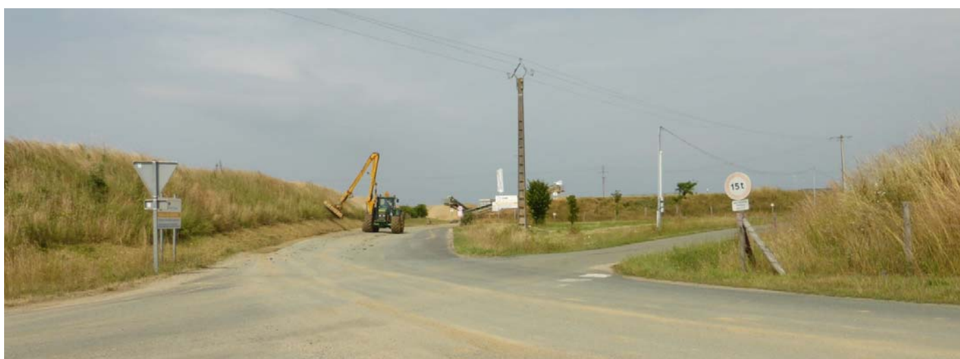
UP35-40-XXX La carrière des Alleuds a fait l'objet d'aménagement de talus qui limite l'impact paysager de l'activité (Les Alleuds - 2015)
