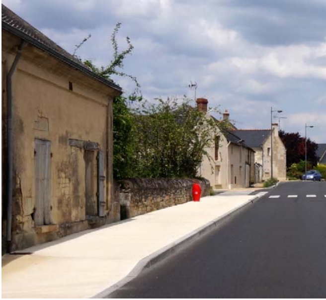
UP35-20-16 Structure urbaine de hameau : Rues dessinées par les maisons et leurs dépendances, sans alignement, orientées différemment avec alternance de maisons hautes et basses, de vides et de pleins, ruelles parfois étroites et de largeur variable (Dénezé-sous-Doué)
