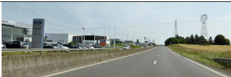
6 Des infrastructures importantes qui drainent et dynamisent ce territoire (Distré)
