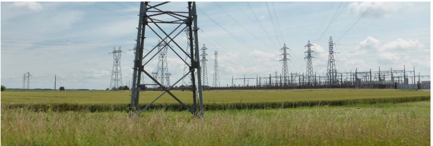
UP35-40-XXX A La Coudray-Macouard, un poste électrique imposant a investi le paysage d'entrée de ville sud de Saumur (La Coudray-Macouard - 2015)
