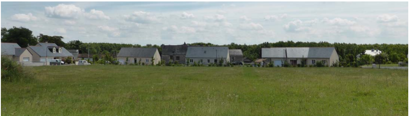
UP35-40-XXX L'urbanisation de Montreuil-Bellay se diffuse sur la rive droite du Thouet sous forme pavillonnaire (Montreuil-Bellay - 2015)
