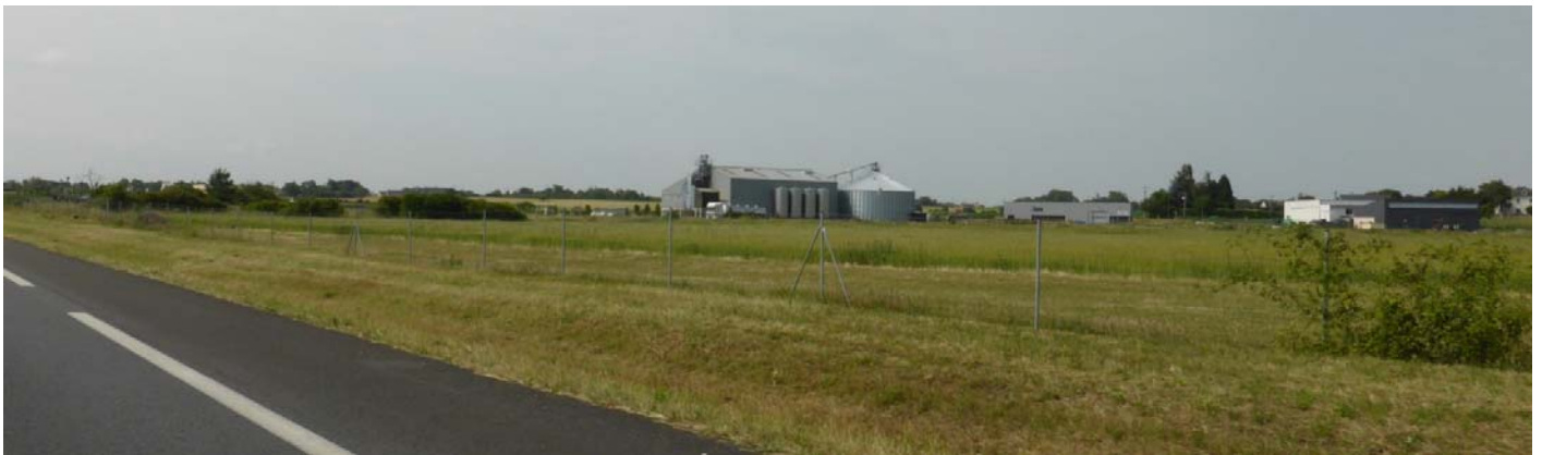
UP35-50-XXX Le développement de la D761 et l'aménagement du contournement d'Ambillou-Château modifient la perception des paysages de frange urbaine et notamment des zones d'activités (Ambillou-Château)
