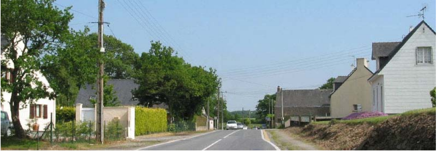
SSUP34C1 Paysage pavillonnaire rural caractéristique du secteur est de la sous-unité
