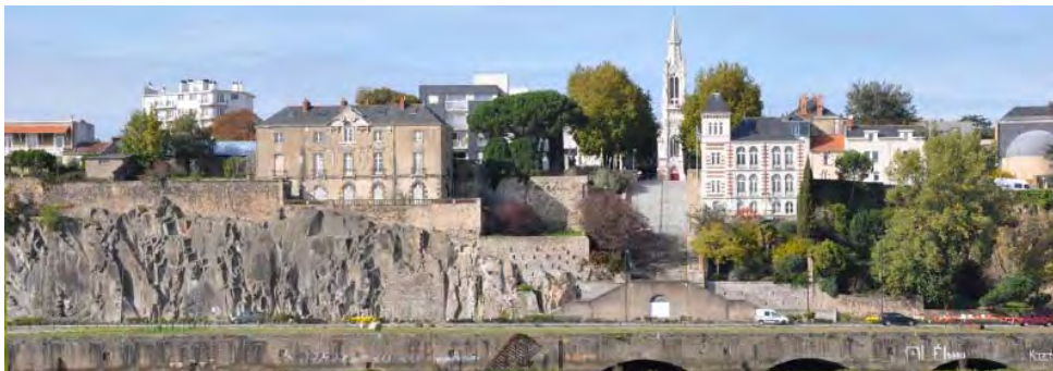
UP31-20-02 Paroi rocheuse du sillon de Bretagne dominant les quais de la Butte Sainte Anne (Nantes)
