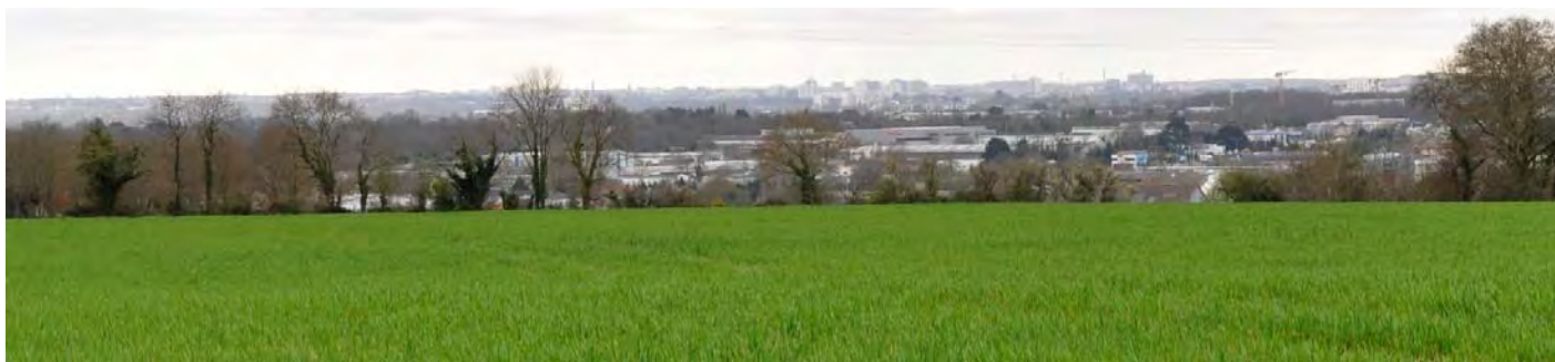
UP31-33-03 Une ceinture d'activités qui marque les franges et les entrées de l'agglomération nantaise (Thouaré-sur-Loire)
