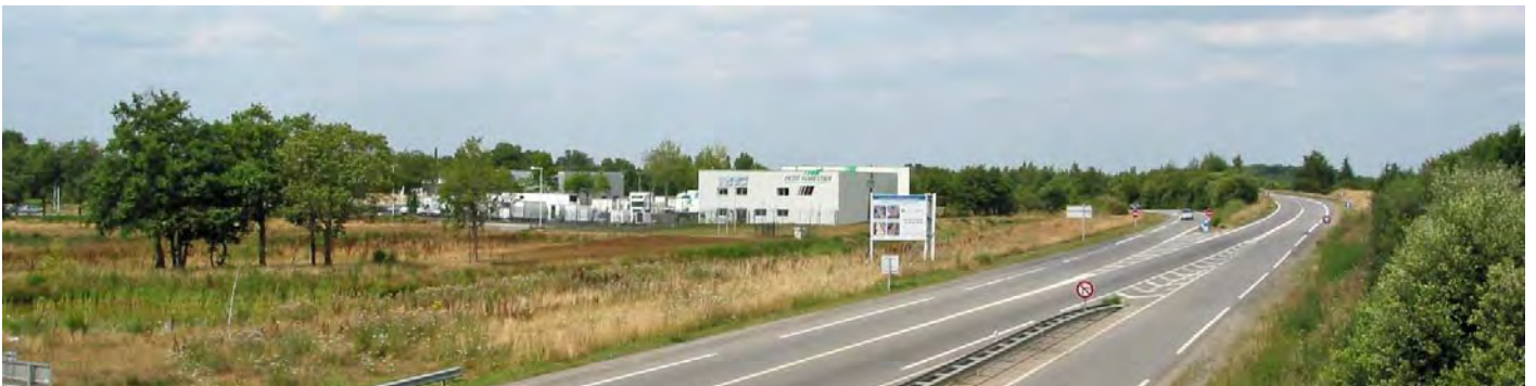
UP31-34-06 Des infrastructures portent leur propre paysage et créent des ruptures dans l'espace périurbain (Les Sorinières)
