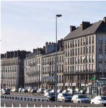
UP31-20-03 Instabilité du sol lisible sur les façades bancales des quais de Loire (Nantes)
