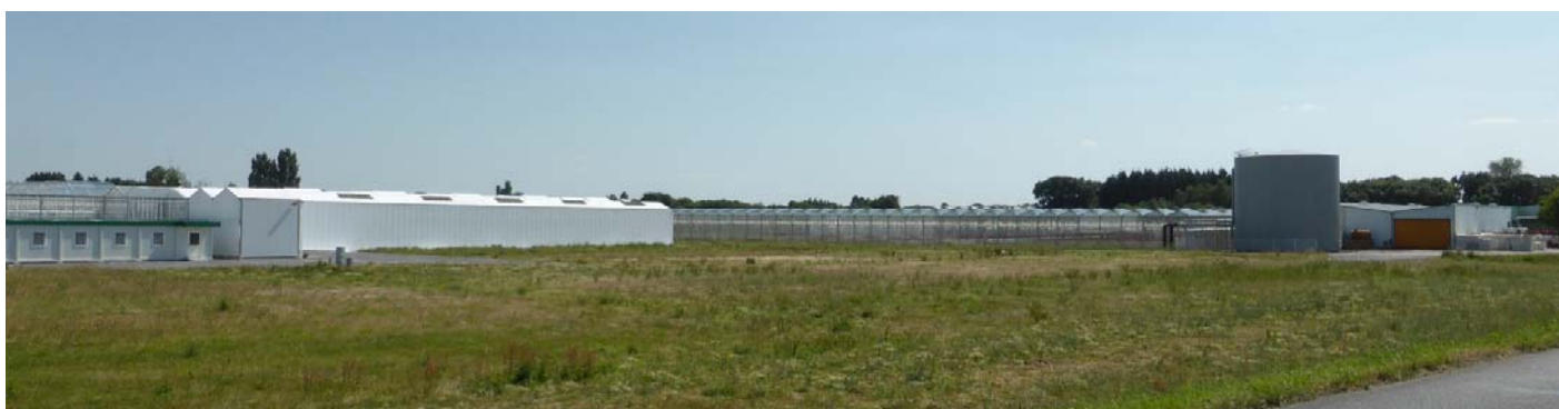
UP30-40-22 A l'approche de l'agglomération nantaise, autour de Saint-Julien-de-Concelles, le développement de l'activité maraîchère multiplie les serres dans le paysage des bords de Loire (Saint-Julien-de-Concelles - 2015)
