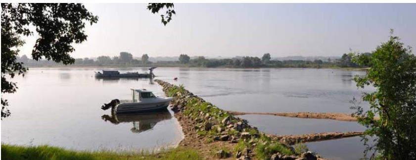
UP30-20-14 des épis qui concentrent des usages de loisirs et marquent le paysage du fleuve en étiage (Montrelais)
