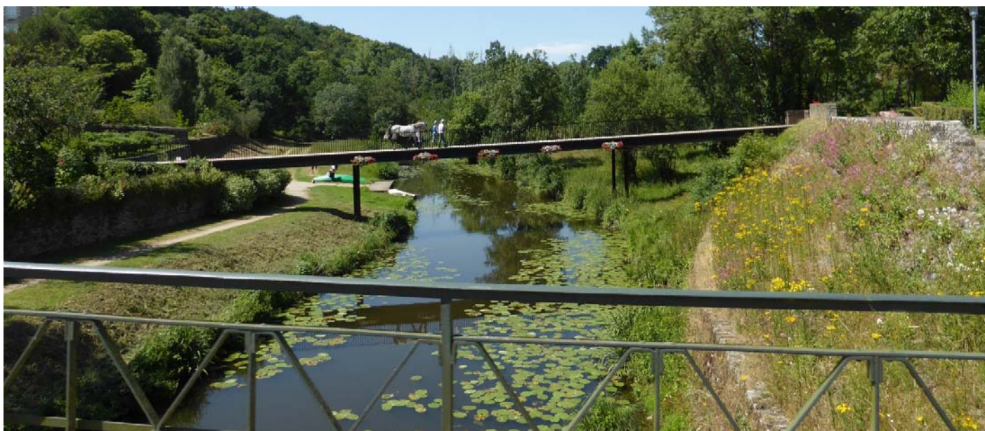
UP30-50-01 La valorisation du rapport de la ville à l'eau : entre aménagement des sentiers pédestres, création de passerelles et entretien des berges (Oudon)
