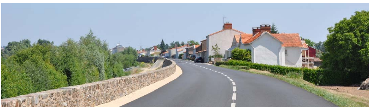
UP30-20-36 La levée habitée de la Divatte qui isole le polder fluvial maraîcher (à droite) des inondations de la Loire (à gauche) (La Chapelle-Basse-Mer)
