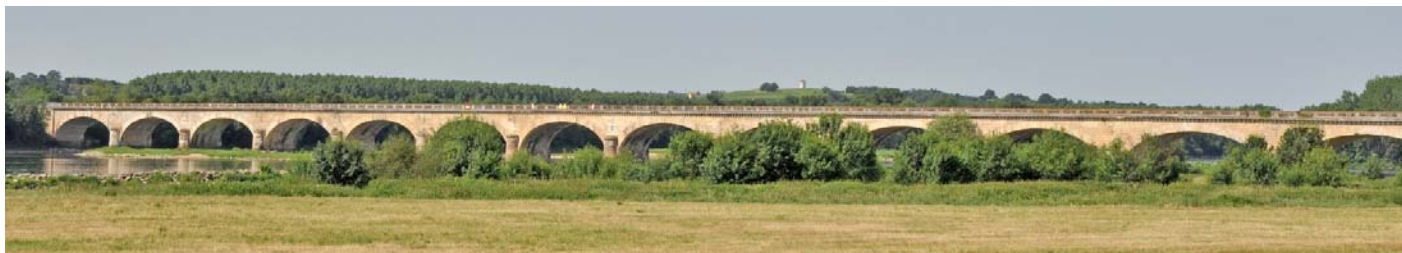
UP30-20-35 Pont ferroviaire de Chalonnes-sur-Loire, un repère marquant de l'espace fluvial (La Possonnière)
