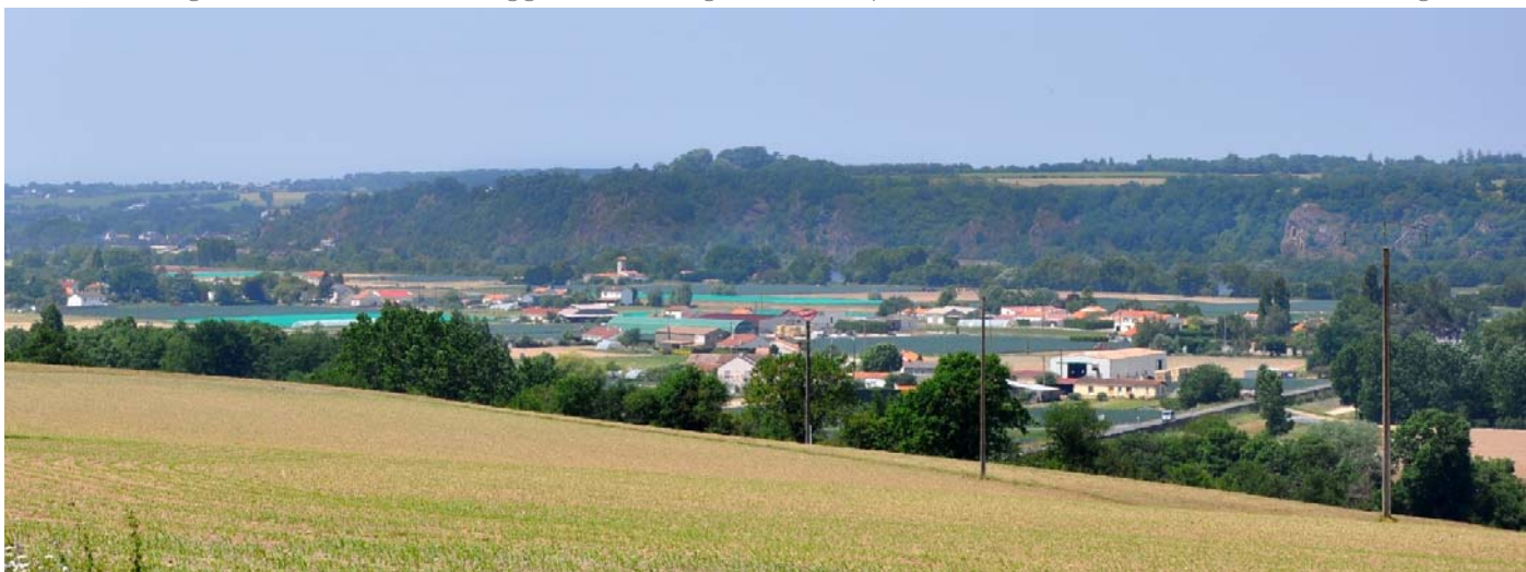
UP30-10-04 Coteau sud doux plongeant sur le polder horticole de la Divatte, dominé par le coteau nord abrupt (La-Chapelle-Basse-Mer)
