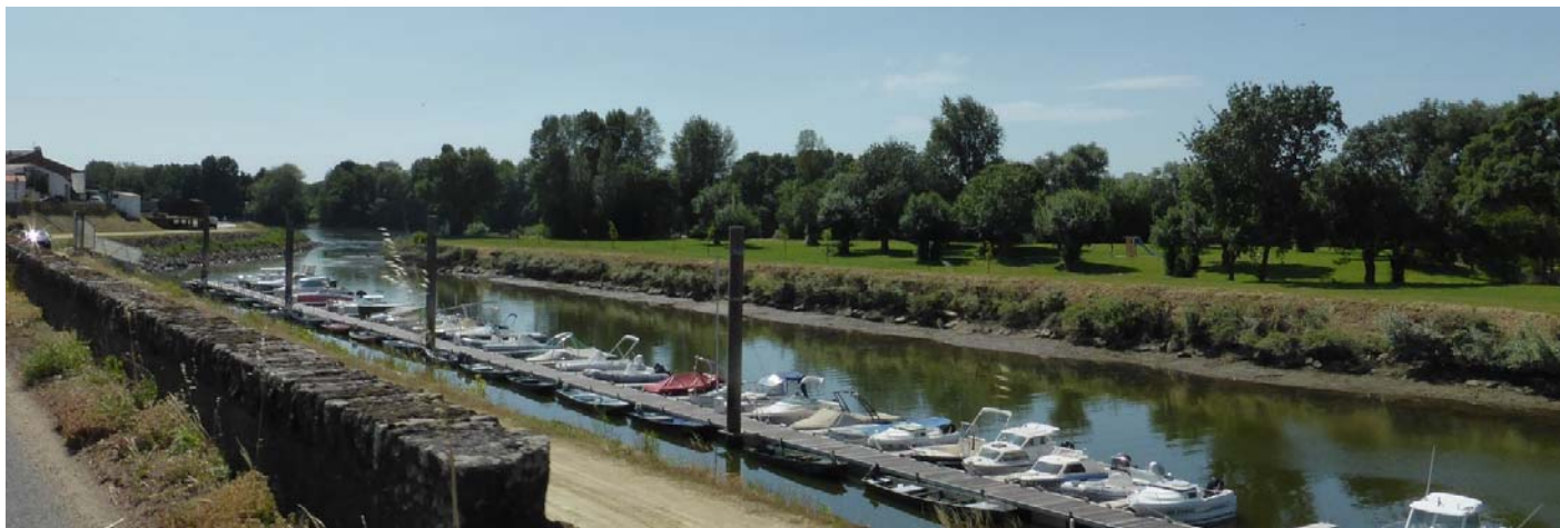
UP30-40-13 Entre parcours de golf, port de plaisance et aménagement d'une piste cyclable : les bords de Loire le long de la levée de La Divatte accueillent de plus en plus d'équipement à vocation récréative (La Chapelle-Basse-Mer - 2015)
