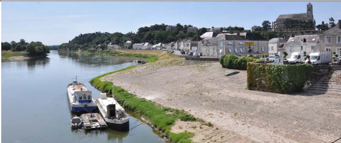
01 Un bourg en promontoire et développant une façade urbaine le long de quais sur la Loire (Montjean-sur-Loire)
