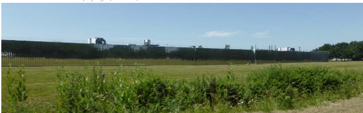
UP30-50-17 Le même bâtiment industriel que sur la photo précédente : Le jeu des expositions ainsi que l'absence d'accompagnement paysager rendent le bâtiment plus visible dans le paysage des abords de la D723 (Le Cellier)
