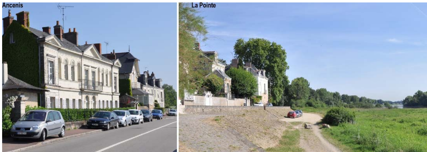
UP30-20-07 Une architecture où la vue sur Loire est valorisée par les larges ouvertures et les cabines (Ancenis-La Pointe)
