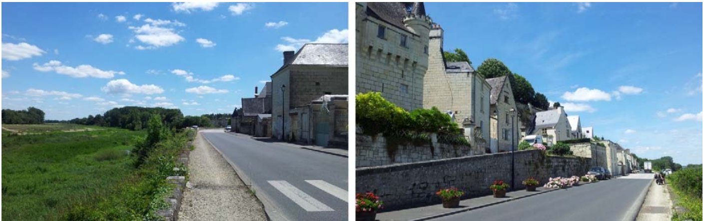
UP29-30-01 Urbanisation rive gauche en appui sur le coteau calcaire, patrimoine bâti riche ouvert sur la Loire (Souzay-Champigny)
