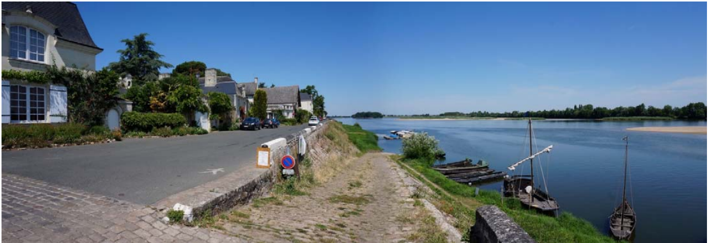
UP29-20-10 Dégagement visuel à l'arrivée sur le Thoureil, le patrimoine bâti dialogue avec le fleuve ... (Le Thoureil)
