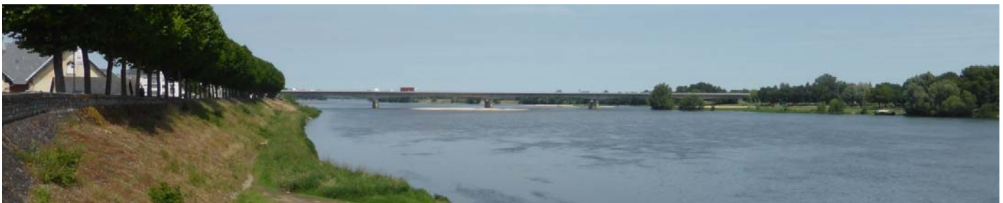
UP29-40-XXX A Saumur le franchissement de la Loire par la D347 a été mis en 2x2 voies en 2010 (Saumur - 2015)
