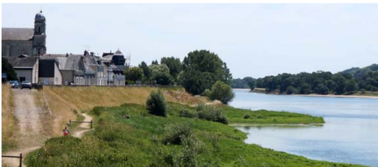
UP29-20-31 La levée ligérienne, premier plan maçonné entre Loire et bourg (Saint-Clément-des-Levées)
