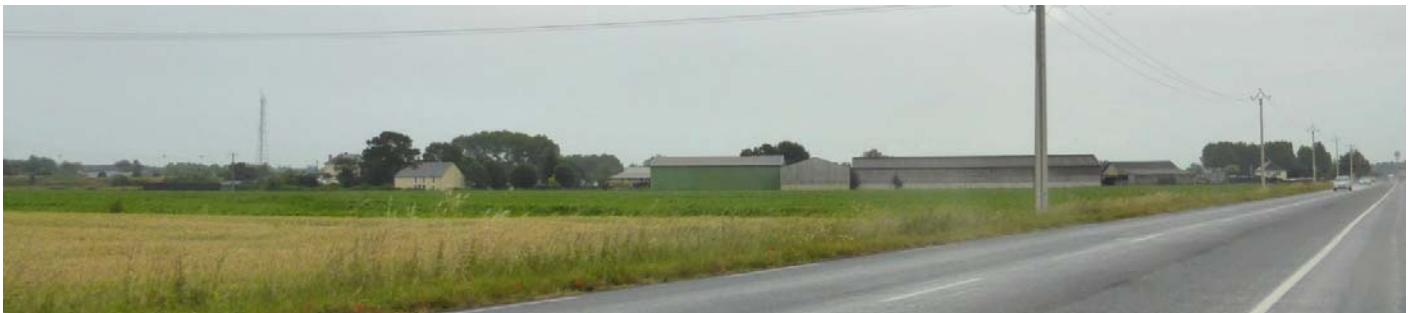
UP29-50-XXX Malgré l'absence de haie filtrante, des volumes et une colorimétrie adaptés permettent de limiter l'impact paysager des bâtiments agricoles dans le paysage ouvert (Vivy)
