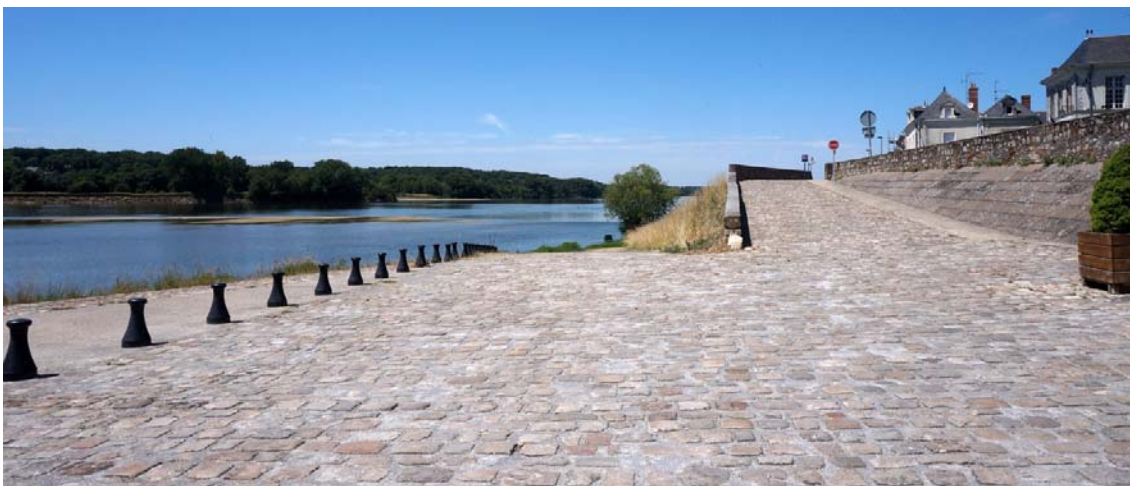
UP29-20-25 Registre de quais et cales préservé et réaménagé pour accueillir du stationnement tout en permettant l'accès au fleuve (Saint-Clément-des-Levées)
