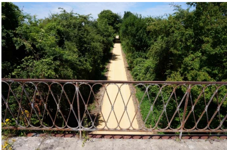
UP28-40-XXX Une voie verte entre Baugé et Longué est en cours d'aménagement et empreinte le tracé de l'ancienne voie ferrée (Le Vieil-Baugé - Baugé-en-Anjou - 2015)
