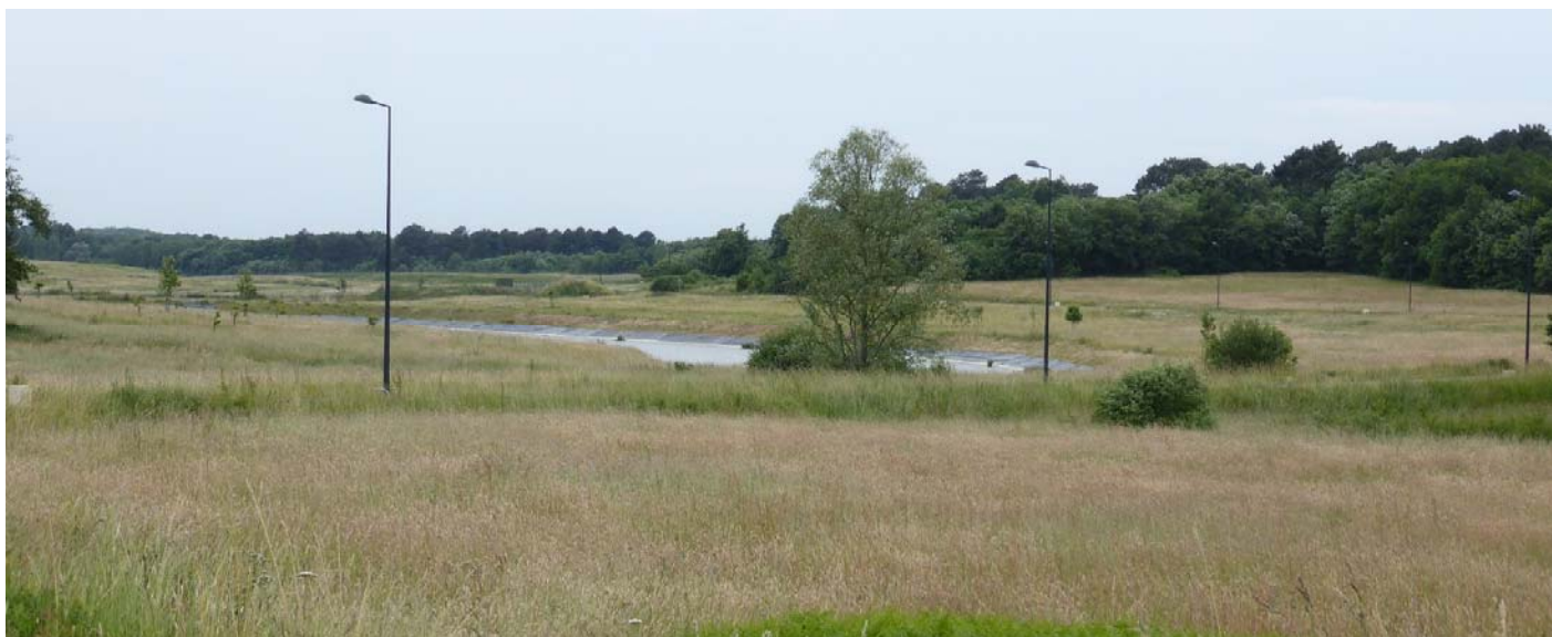
UP28-40-XXX A proximité de l'aéroport d'Angers-Marcé, la mise en place des réseaux (voiries, éclairage...) maille une zone de 40 ha où les bâtiments d'activités sont absents (Marcé - 2015)
