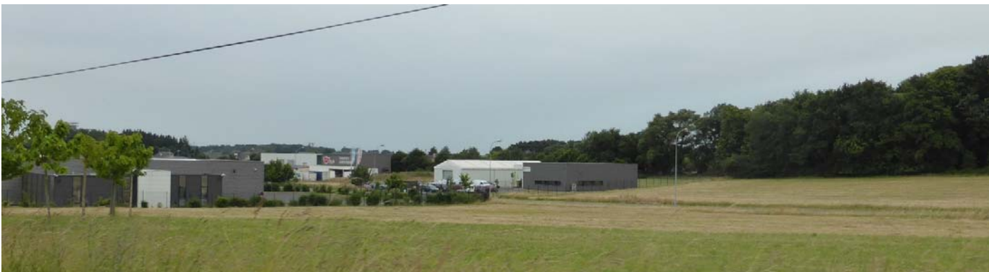
UP28-40-XXX A l'est de Baugé-en-Anjou, le long de la RD766, les extensions urbaines sont les conséquences du développement des zones d'activités. Les bâtiments d'activités composent le paysage de frange (Baugé-en-Anjou – 2015)
