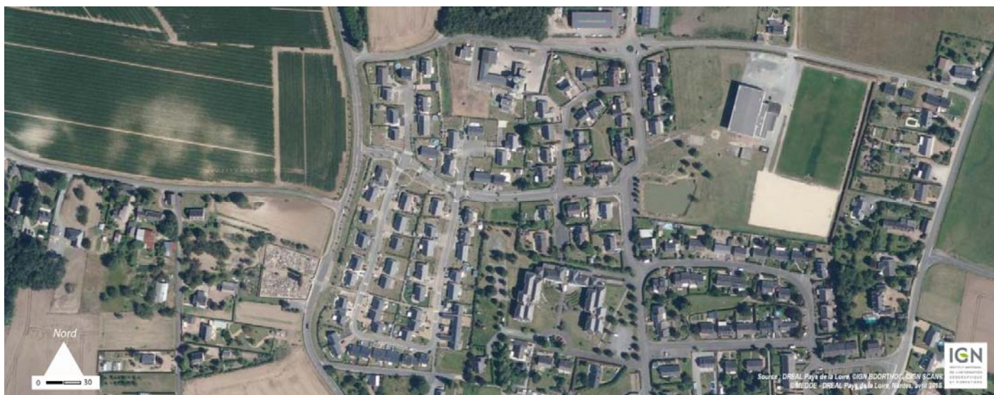
UP28-40-XXX A Bauné, un modèle d'extension urbaine sous forme de lotissements (2013)
