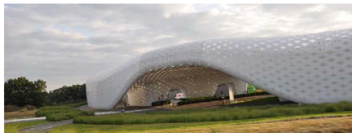
27-40-08 L'Atoll : zone commerciale « nouvelle génération » (Beaucouzé - 2014)
