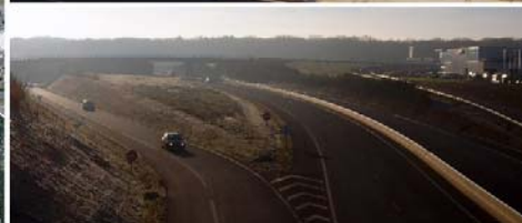
27-20-12 La RD 106 crée une rupture dans les paysages urbains de l'agglomération
