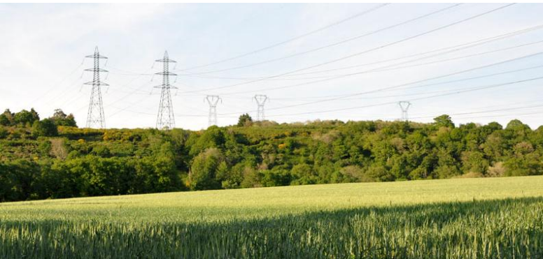
SSUP12D3 : lignes électriques : Lignes électriques sur le coteau boisé du Sillon de Bretagne au droit de la centrale de Cordemais
