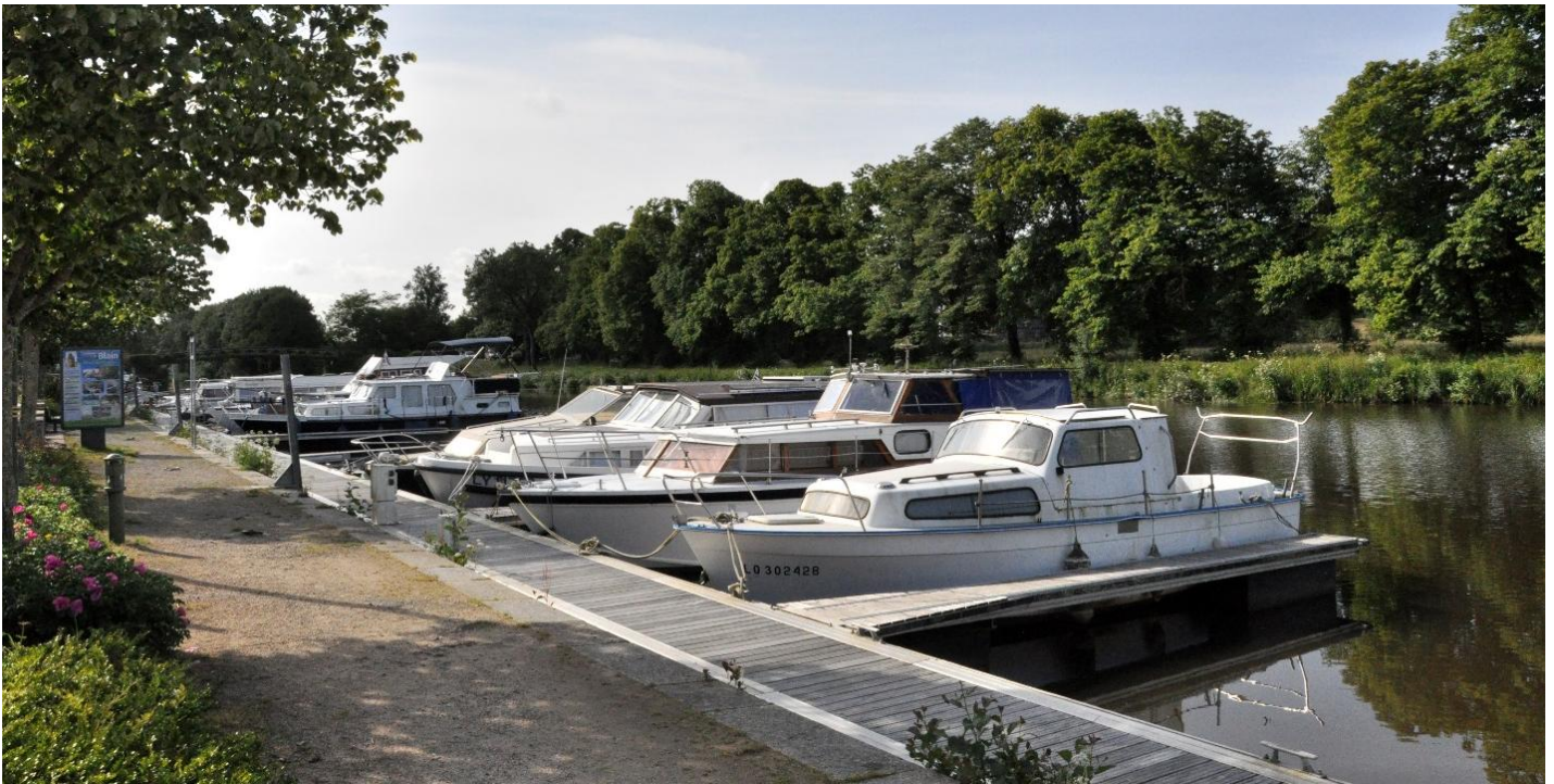
IMAGE haut SSUP12A1 canal Paysages linéaires et quais du canal de Nantes à Brest (Blain)
