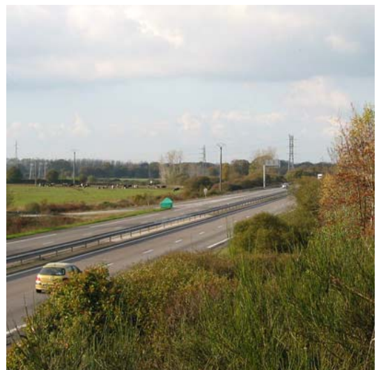
UP23A3 La 2x2 voies Nantes Rennes, une rupture physique et visuelle dans le paysage
