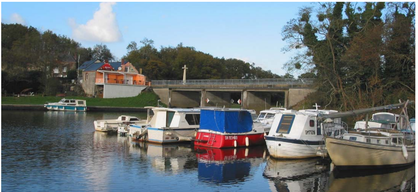
UP23-50-ENJ- Canal de Nantes à Brest, au niveau de Guenrouet.
