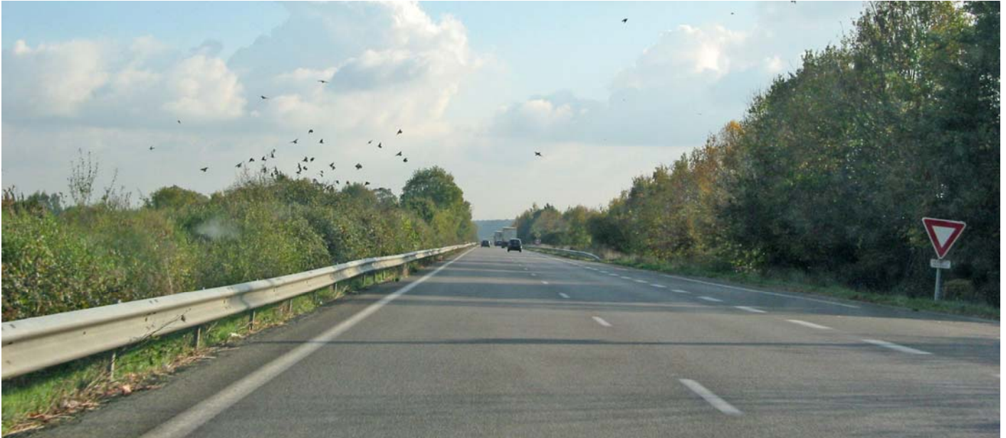
UP23_desc7 Tunnel vert de la route des estuaires (RN137) à hauteur de Derval
