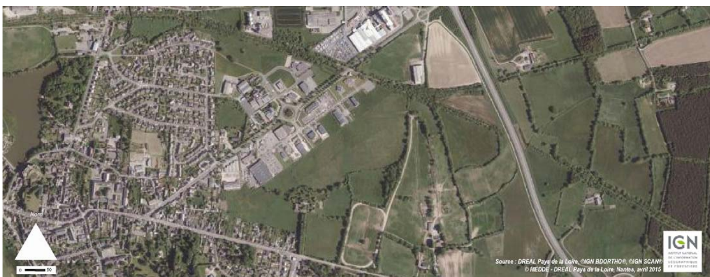
UP22-40-XXX Les développements urbains et l'aménagement d'une voie de contournement de bourg de Pouancé contribuent à enclaver les terrains agricoles (2012)
