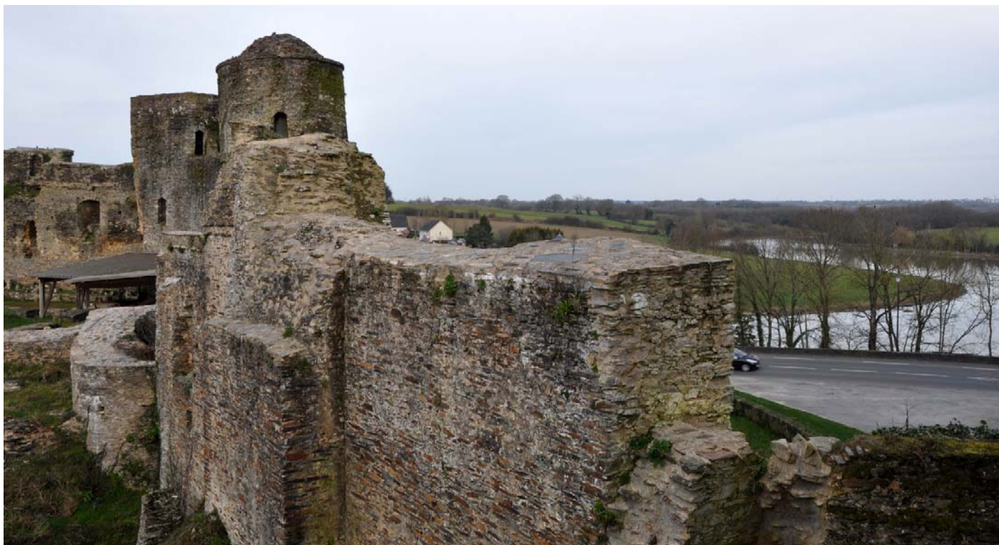
UP22-20-23 Forteresse de Pouancé dominant la vallée de la Verzée (Pouancé)
