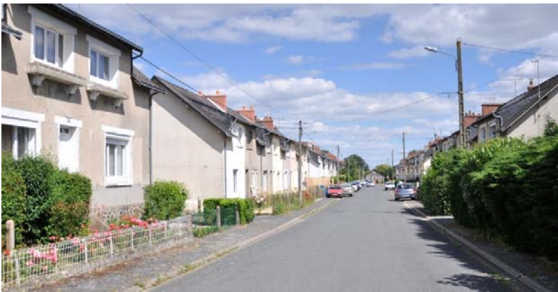
UP22-20-14 Quartier d'habitations ouvrières de type coron de la Cité du Bois II (Nyoiseau)
