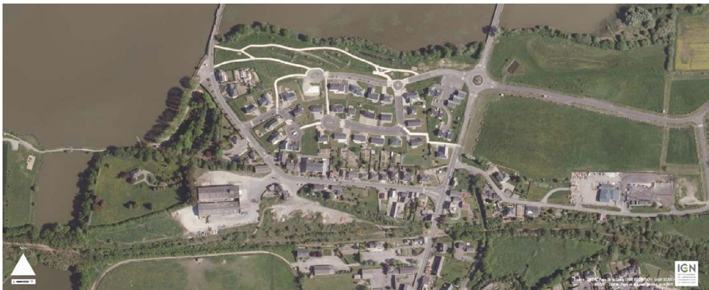
UP22-40-XXX Les développements urbains récents au nord de Pouancé surplombent l'étang de Saint-Aubin (2012)
