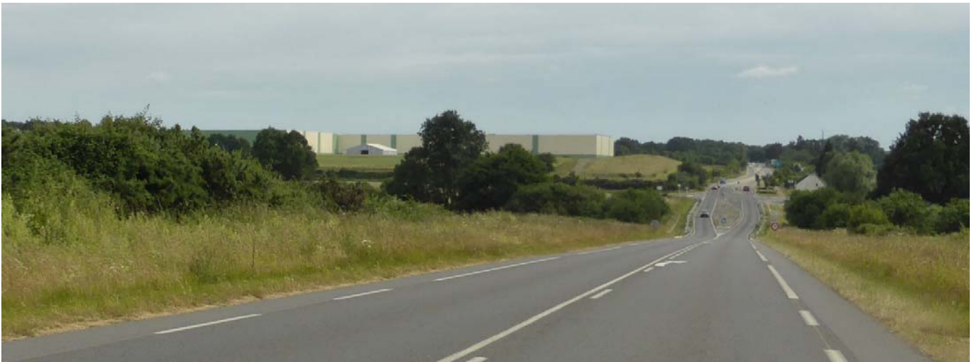
UP22-50-XXX Le positionnement des bâtiments d'activités aux abords des axes principaux et le positionnement en point haut des bâtiments accroît leur visibilité sur de longue distance (Segré)
