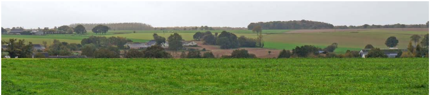
UP22-20-19 Des bâtiments d'élevage qui accompagnent les anciens corps de fermes et se distinguent par leur volume et leurs matériaux de construction (La Selve-Craonnaise)
