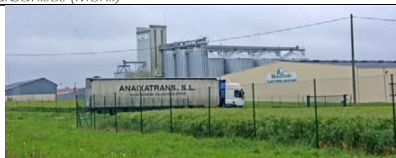
5 Des témoins d'une industrie agroalimentaire active : le silo de Cossé-Le-Vivien
