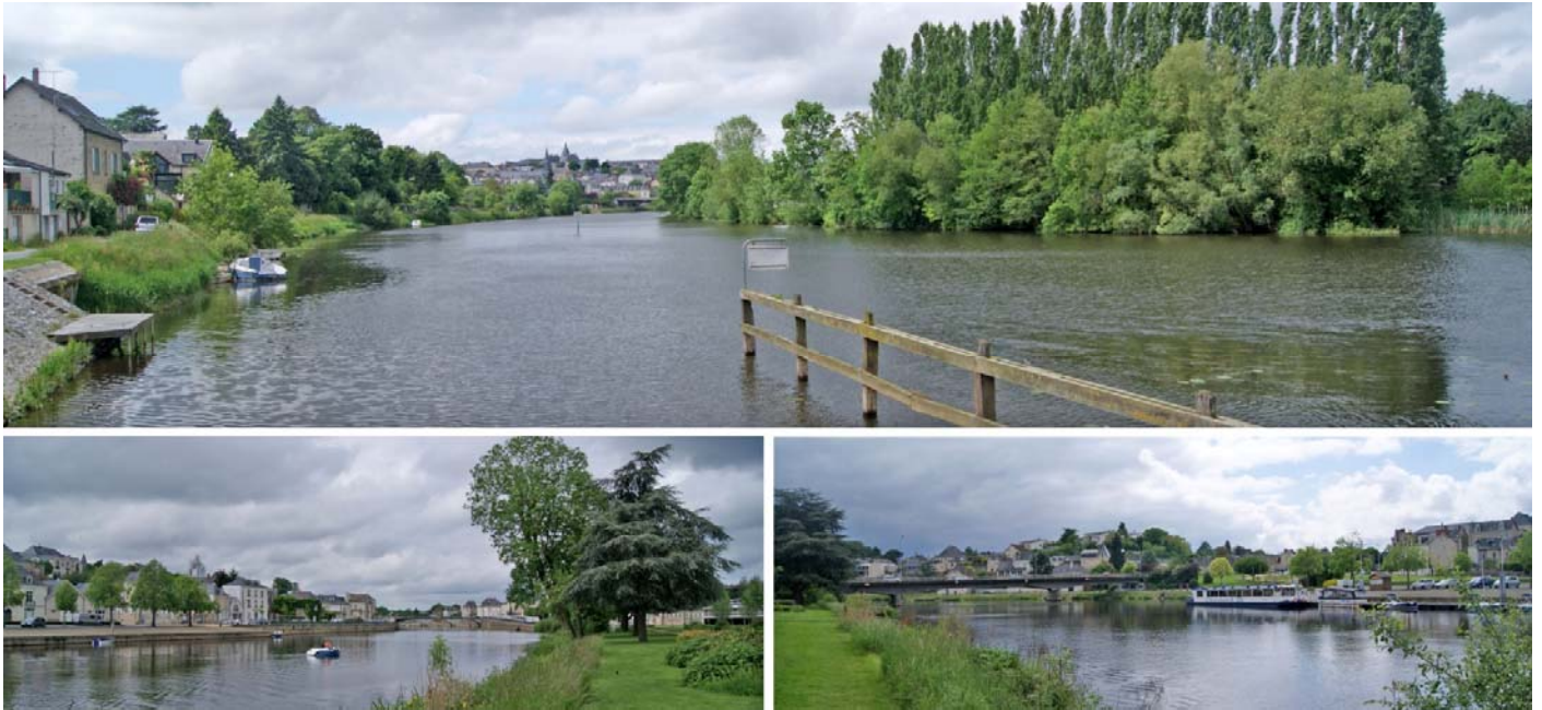
UP21-30-02 Ambiance patrimoniale de Château-Gontier implanté dans la vallée de la Mayenne, axe fédérateur structurant de sa composition urbaine (Château-Gontier)
