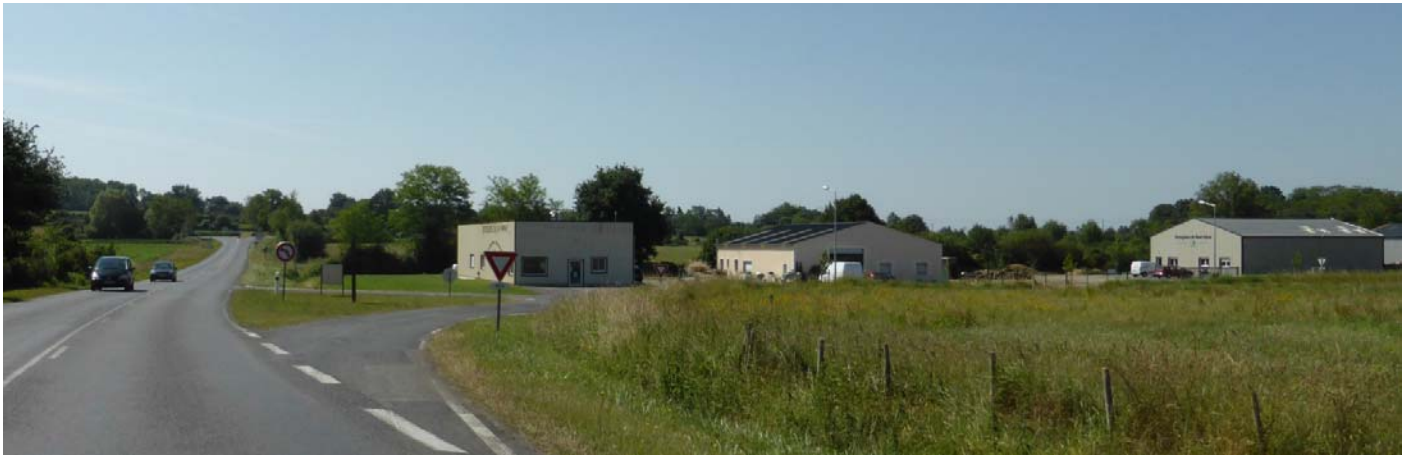
UP20-50-XXX Une implantation en bord de voie sans accompagnement paysager tend à renforcer la visibilité des bâtiments d'activités (Etriche)
