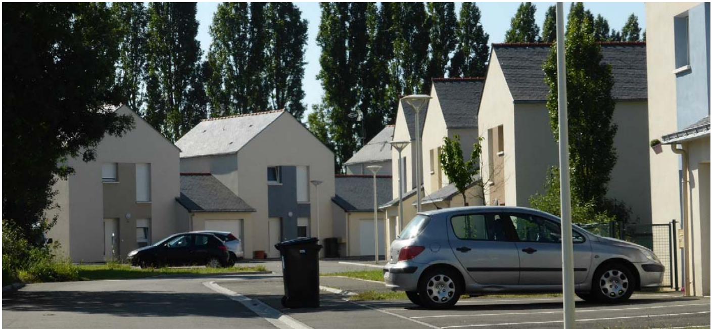
UP20-40-XXX Au Lion d'Angers, les extensions récentes prennent également la forme d'un habitat individuel groupé qui immisce de nouvelles compositions architecturales dans le paysage urbain (Le Lion d'Angers - 2015)
