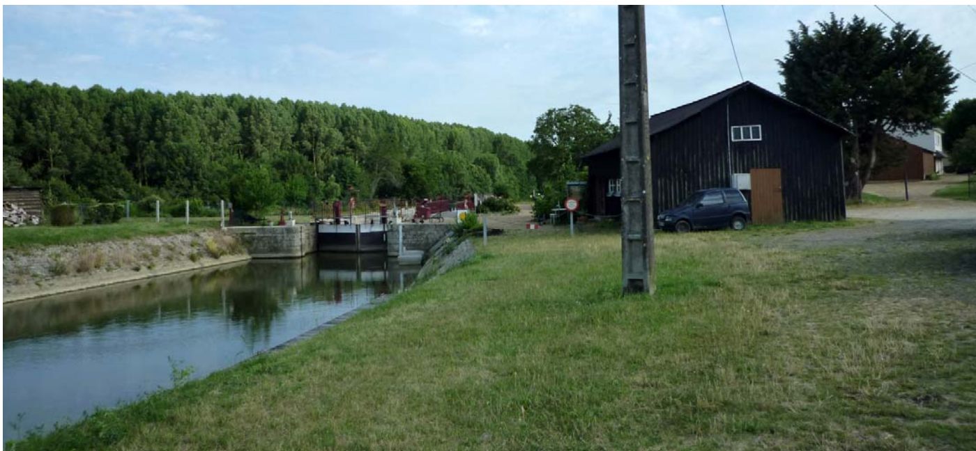
UP20-32-03 Ecluse sur la Sarthe (Brissarthe)
