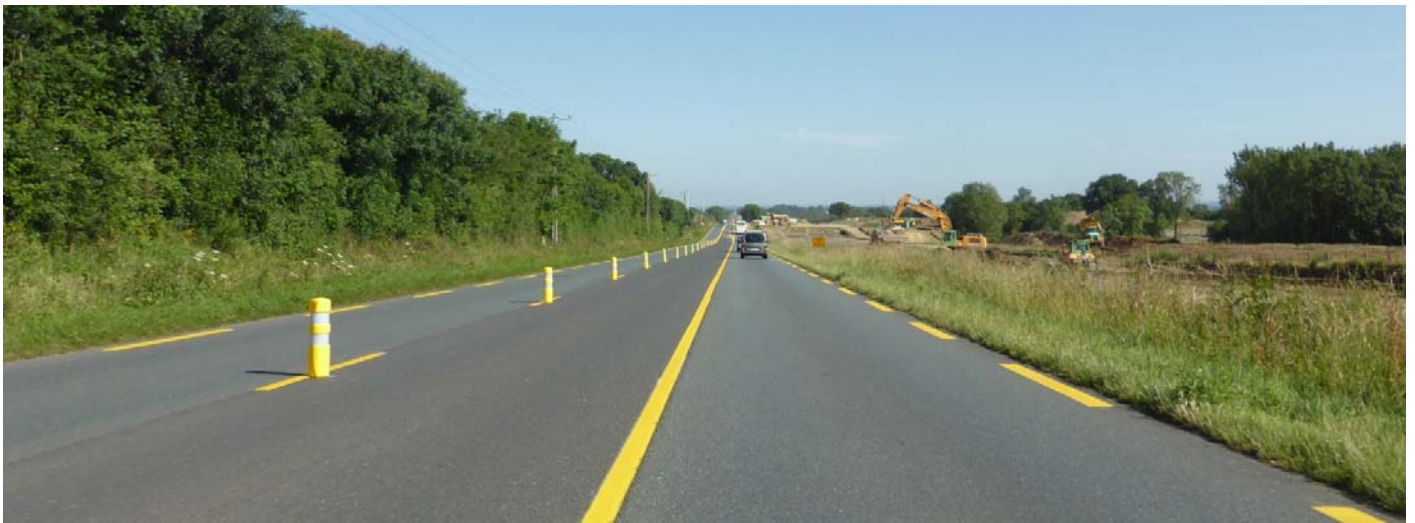
UP20-40-XXX La mise en 2x2 voies de la D775 entre La Membrolle-sur-Longuenée et le Lion-d'Angers est en cours d'aménagement (Pruillé - 2015)
