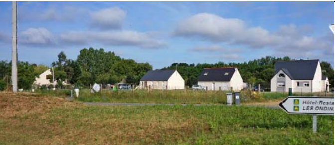
7 Extension urbaine pavillonnaire à l'appui d'un écart le long de la Sarthe (Le Porage - Etriché)
