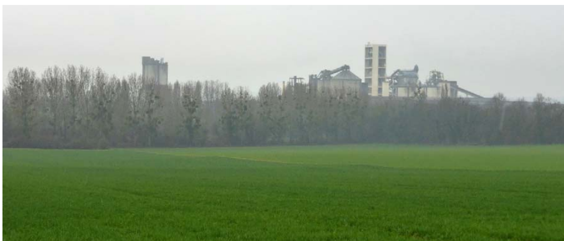
UP18-40-12 - A l'inverse du site d'extraction peu visible depuis les alentours, la cimenterie de Villiers au Bouin constitue un élément marquant du paysage (Chenu – 2015)
