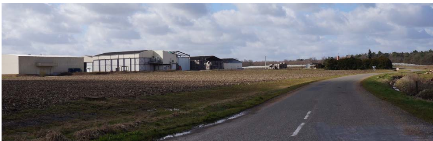
UP18-40-05 - La présence de l'activité arboricole dans le paysage est également signalée par la présence des bâtiments imposants (Saint-Germain-d'Arcé – 2015)
