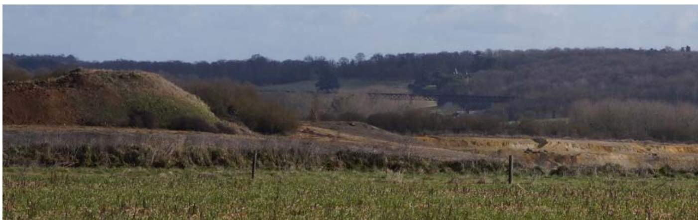
UP18-20-1bis: Viaduc de l'école Eiffel (1866) sur le vallon de Chenu (Saint-Germain-d'Arcé)
