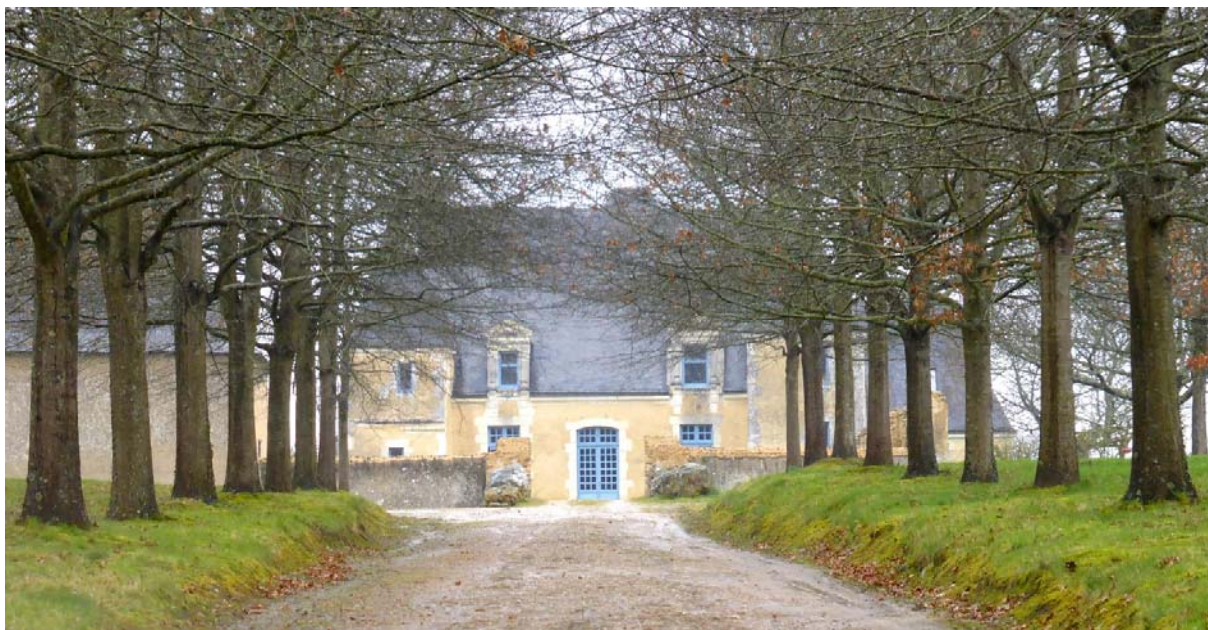
UP17-50-03 - La préservation et la mise en valeur du patrimoine participe à l'attractivité de l'unité paysagère du plateau calaisien (Beaumont-Pied-de-Bœuf)
