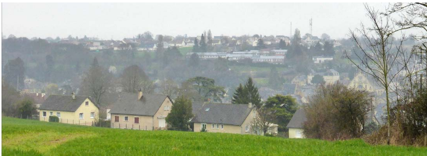
UP17-40-04 - La diffusion de l'urbanisation a investi les coteaux surplombant la vallée et renforce ainsi les phénomènes de co-visibilité (Saint-Calais – 2015)
