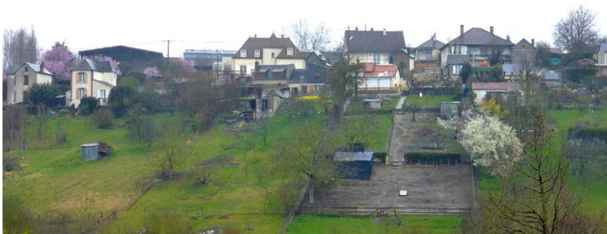
UP17-50-05 - L'urbanisation diffuse des coteaux créé une exposition forte des constructions et des jardins privatifs depuis les coteaux opposés à Saint-Calais (Saint-Calais)
