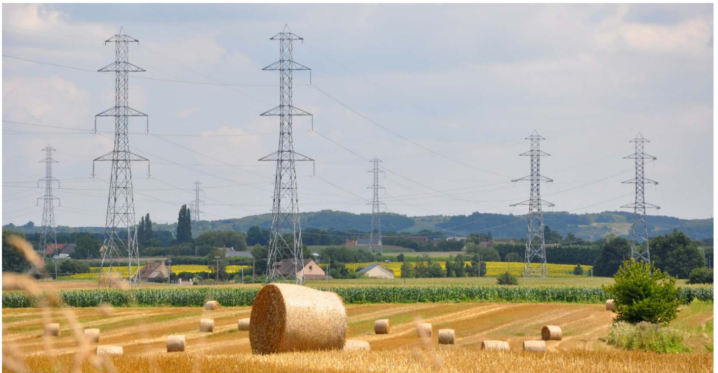
UP16-20-15 Maillage des pylônes électriques qui se densifie à l'approche de l'agglomération mancelle(Téloché)
