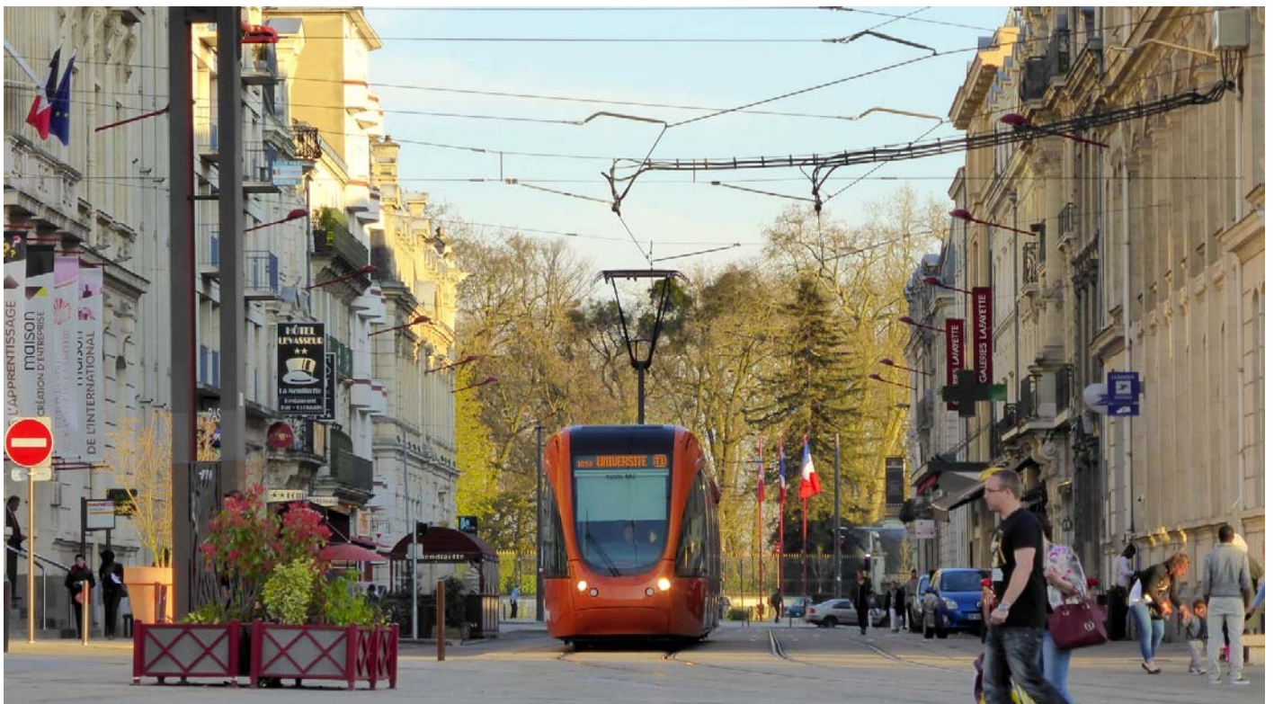
UP15-40-05- Aménagement des voies de tramway et requalification paysagère du centre-ville (Le Mans - 2015)
