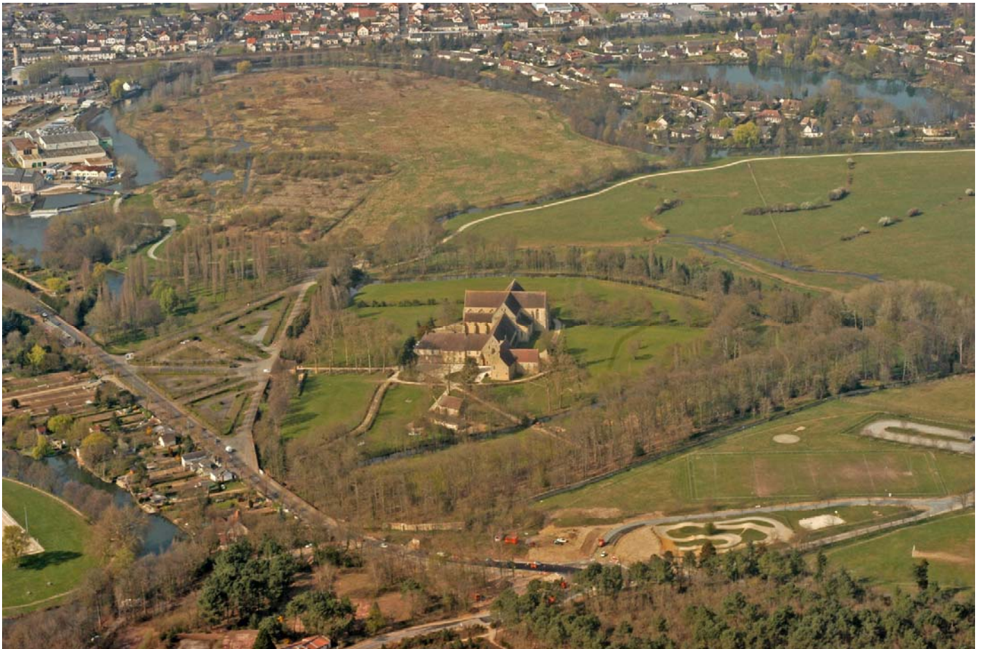
UP15-32-04 L'abbaye de l'Epau, un site patrimonial dans les boucles de l'Huisne, qui s'accompagne de parcs, espaces naturels et nombreux équipements sportifs ou de loisirs (Yvré-l'Evêque)(source CAUE 72 - 2003)
