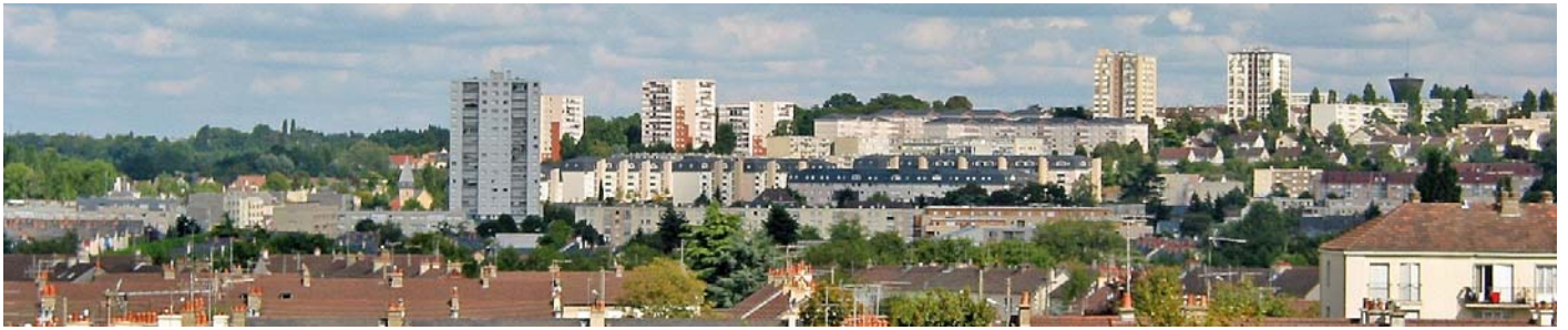
UP15-20-07 Un coteau sud de la Sarthe amplifié par les volumes des immeubles du quartier des Maillets
