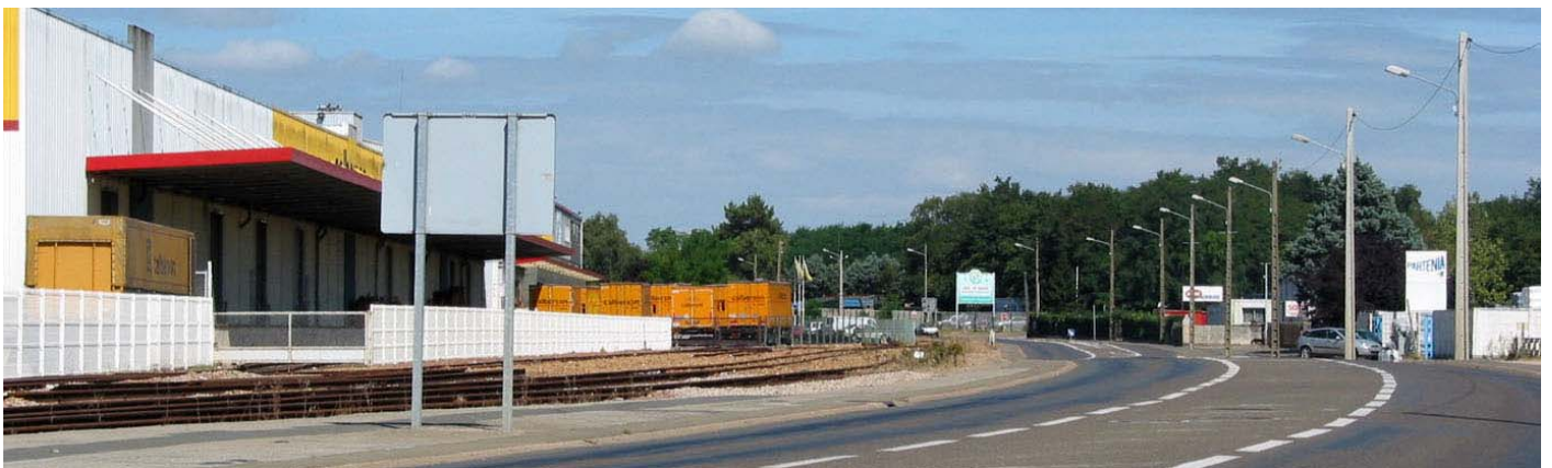
UP15-33-04 Un paysage de zones d'activités marqué par les imposants bâtiments en bardage métallique, les zones de stockage, les enseignes le long des voiries largement dimensionnées (le Mans)
