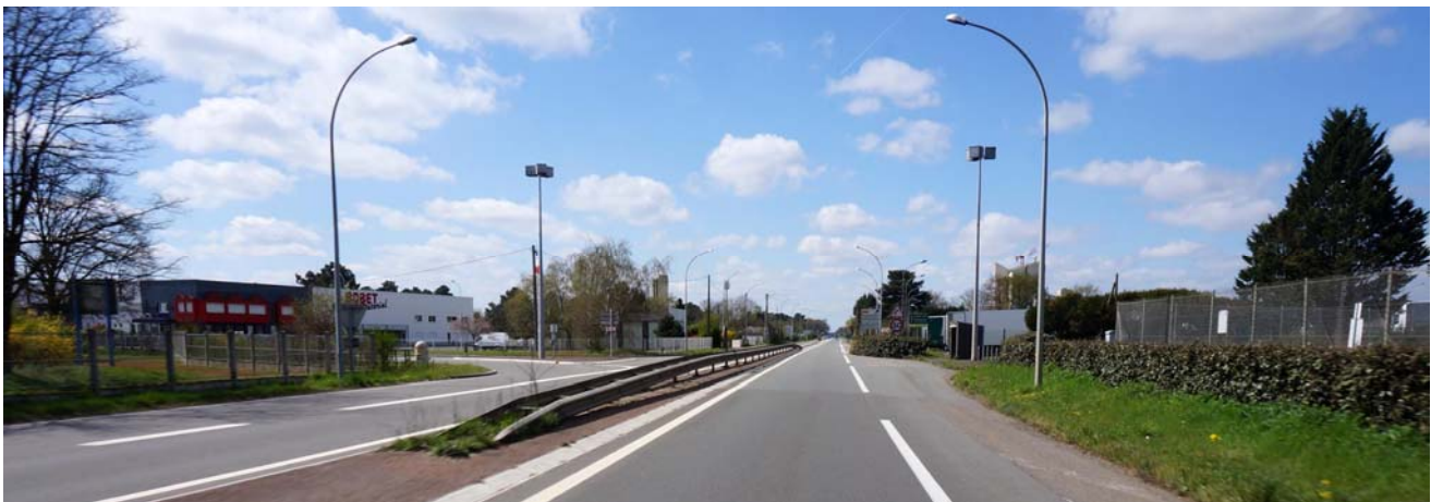
UP15-33-03 Une entrée de ville est marquée par la succession des bâtiments d'activités et leurs espaces servants qui masquent les lisières forestières en second plan (Champagné)
