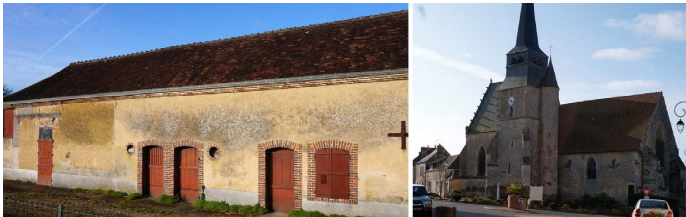
UP14-20-04 Couleurs chaudes du bâti sur un corps de ferme et l'église de Cormes
