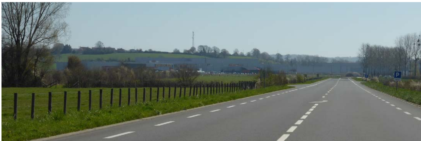
UP14-40-08- La prolifération des nouveaux bâtiments d'activités à proximité de l'échangeur de l'A11 crée de nouveaux repères dans le paysage de La Ferté-Bernard. La mobilisation de volumes très conséquents tend à perturber le rapport d'échelle des paysages (La Ferté-Bernard - 2015)
