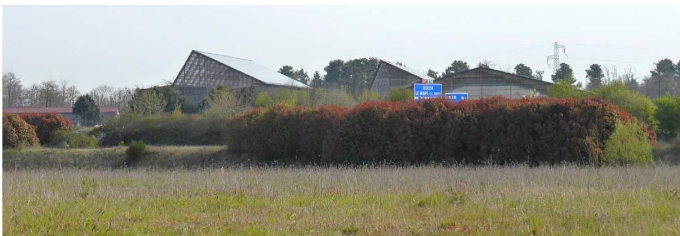
UP13-40-19 - La construction du bâtiment du Pôle Européen du Cheval constitue un nouveau repère visuel aux abords de l'A11 (Yvré-L' évêque - 2015)
