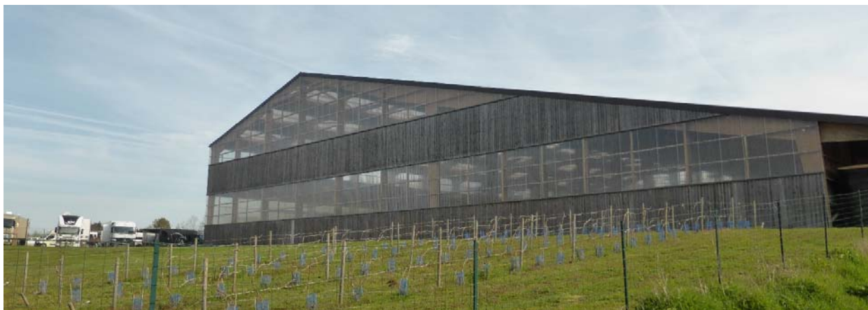
UP13-40-18 - La construction du bâtiment du Pôle Européen du Cheval constitue un nouveau repère visuel aux abords de l'A11 (Yvré-L' évêque - 2015)
