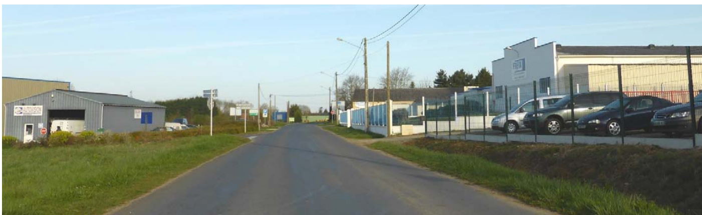
UP13-40-10 - A l'image du développement résidentiel, l'implantation des bâtiments d'activités s'effectue de manière peu dense, le long des axes structurants (Bonnéttable – 2015)
