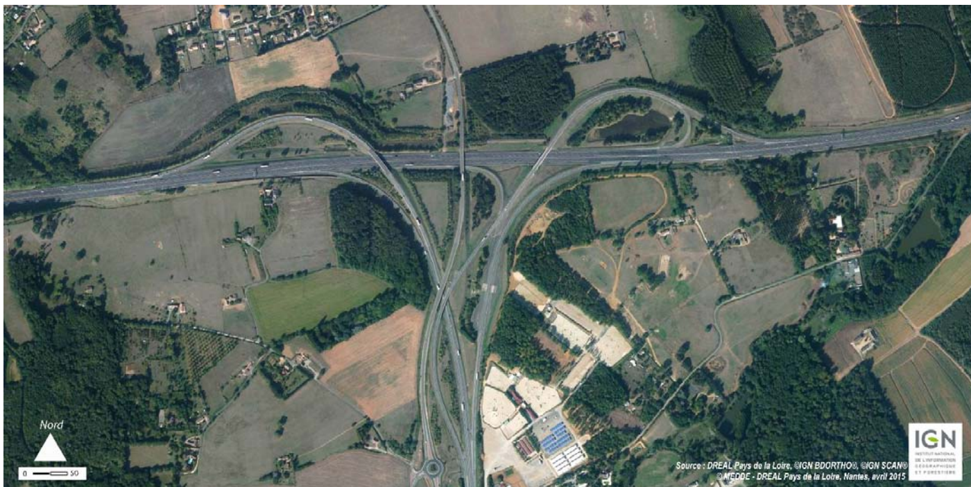
UP13-40-16 - A Yvré-L'évêque, l'aménagement de l'échangeur de l'A11 accentue le poids des infrastructures dans le paysage au nord-ouest de Le Mans et participe à la création de délaissés. Sur ce secteur, le Pôle Européen du Cheval prend désormais position (2010)
