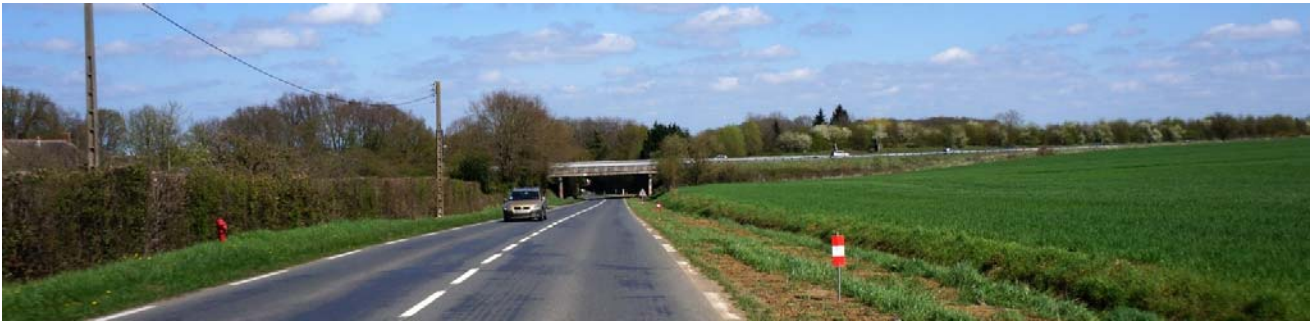
UP13-10-05 Rupture physique et visuelle de l'A11 (Sargé-lès-le-Mans)
