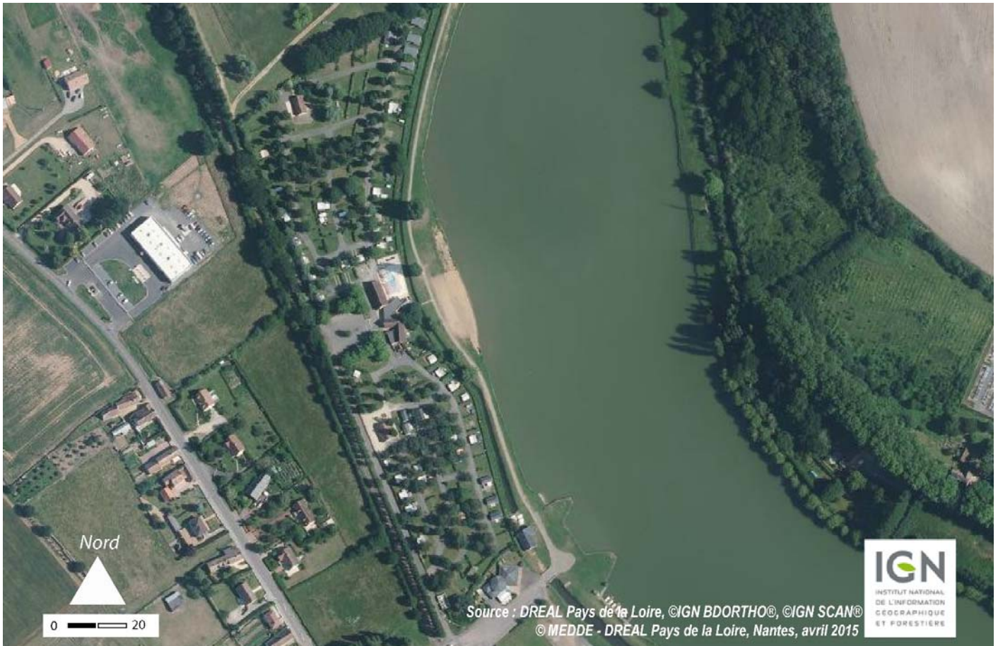
UP13-40-13 - A Tuffé, le développement touristique du secteur se matérialise par l'aménagement d'un terrain de camping entre le lac et la ligne de chemin de fer (Tuffé – 2010)
