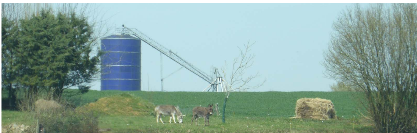
UP12-40-04 - Une intervention simple et radicale souligne la force de ces silos modernes aux couleurs qui se donnent à voir. (Marolles-les-Braults – 2015)
