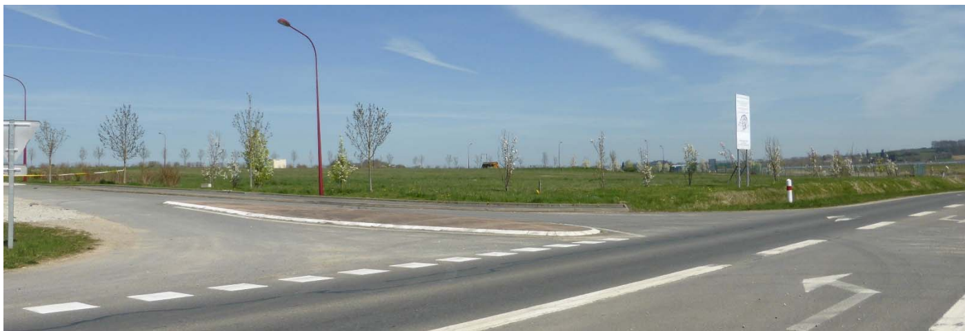
UP12-40-17 - Le développement des infrastructures contribue motiver le développement de zones d'activités, qui bien que viabilisées, prennent le visage de zone « fantôme ». (Coulombiers – 2015)
