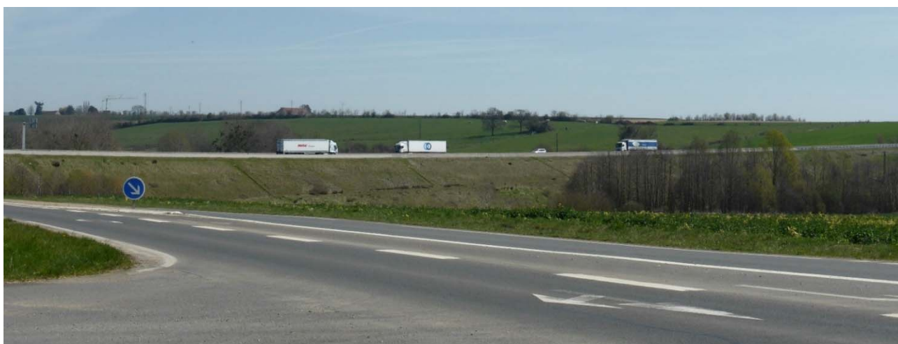
UP12-40-16 - Le développement des infrastructures contribue à modifier les paysages, ici les remblais créent une forte rupture des continuités paysagères et biologiques (Coulombiers - 2015)
