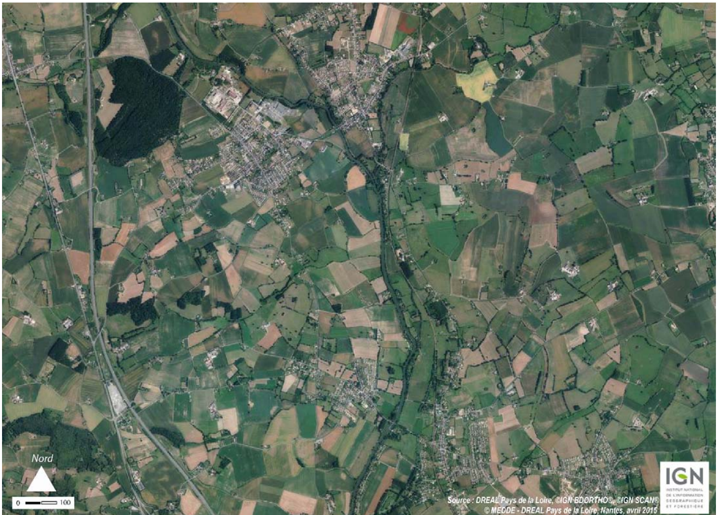
UP11-40-17 - La pression mancelle se matérialise par des développements pavillonnaires conséquents qui se font en extension des bourgs, mais également en diffus sur les coteaux de la vallée (2010)
