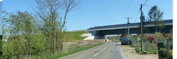
6 Ouvrage de la LGV en cours de réalisation, traversant la vallée selon un axe est-ouest - Neuville-sur-Sarthe
