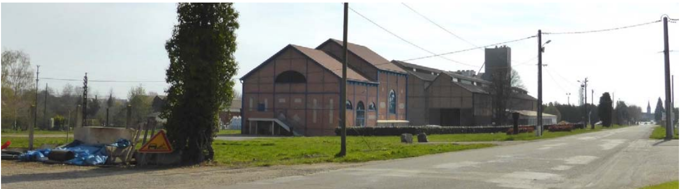
UP11-40-10 - Les anciens bâtiments industriels témoignent d'une qualité architecturale durable, symbole de fierté et de respect du territoire qui font aujourd'hui en partie l'objet d'une réhabilitation (Sainte-Jamme-sur-Sarthe - 2015)
