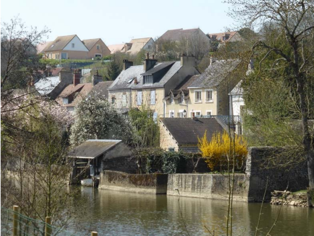
UP11-40-09 - Les extensions pavillonnaires sur les plateaux créent des enjeux en termes de cohabitation paysagère avec le patrimoine ancien (Fresnay-sur-Sarthe - 2015)
