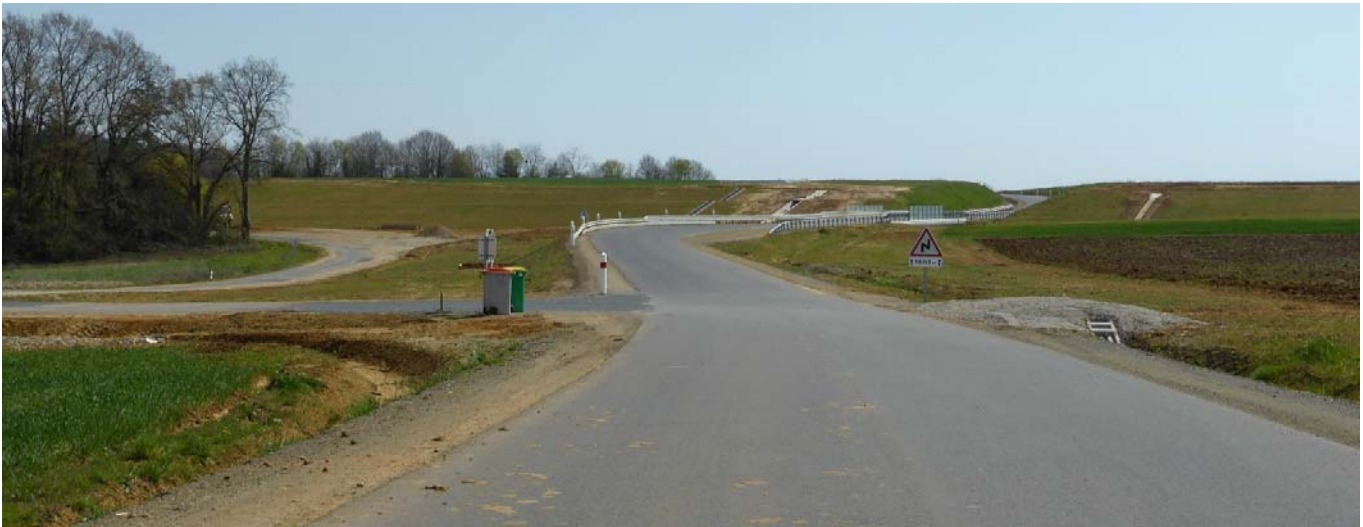
UP10-40-14 -- La multiplication des réseaux, des remblais, des délaissés s'accélère avec le développement de la ligne LGV au sein de l'unité paysagère (Lavardin – 2015)
