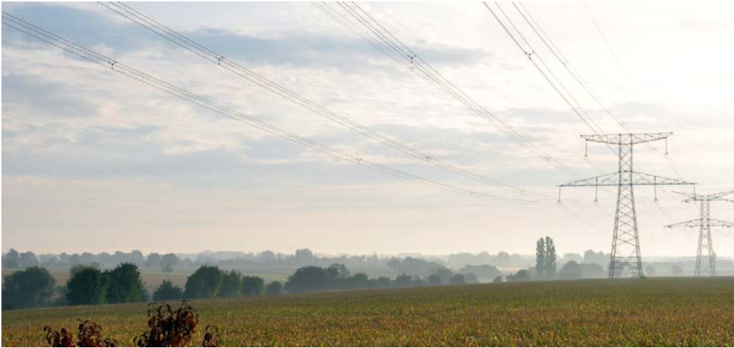
UP10-32-01 Paysage du plateau ondulé cultivé marqué par les infrastructures électriques (
