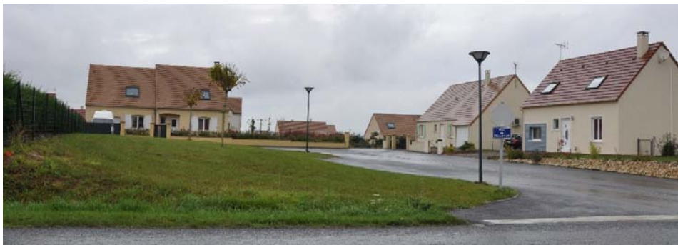
09-50-02 Retrouver la qualité des trames urbaines traditionnelles pour limiter la banalisation des quartiers pavillonnaires (Conlie)
