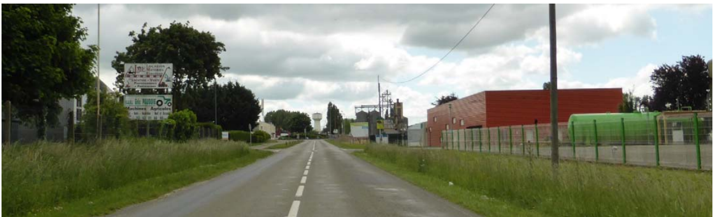
UP08-40-XXX Les bâtiments d'activités composent l'entrée de ville d'Evron depuis la RD 7 (Brée – 2015)
