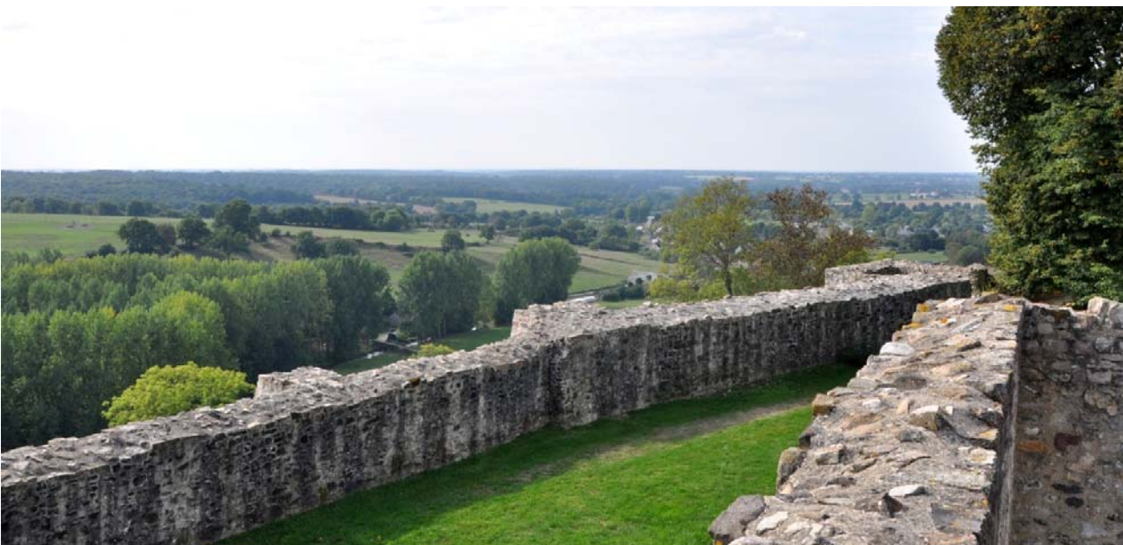
UP8-20-38 Enceinte de Sainte-Suzanne ouvrant sur le paysage du sud des collines du Maine (Sainte-Suzanne)
