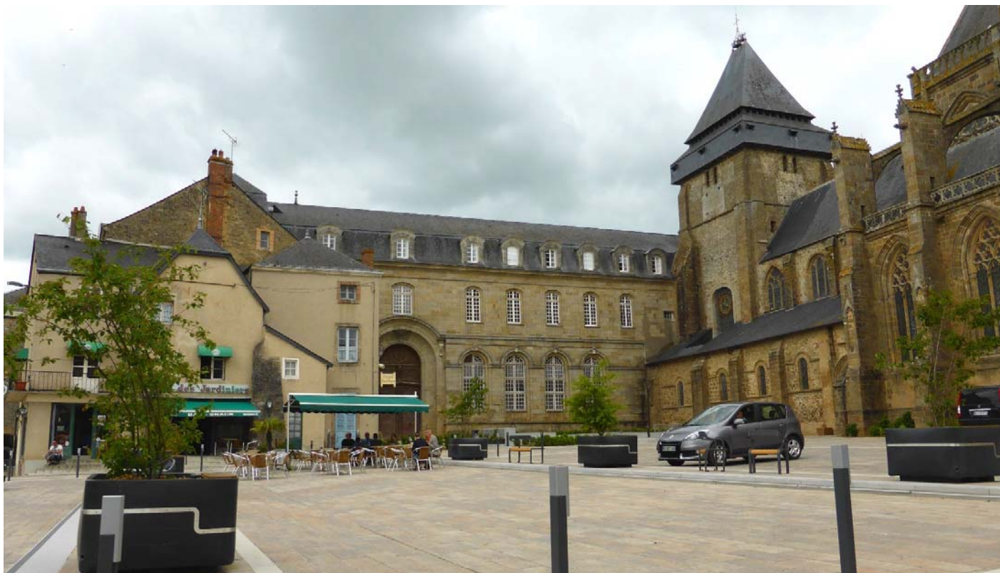
UP08-40-XXX Le centre d'Evron a fait l'objet d'une requalification de l'espace public qui favorise la mise en scène des éléments patrimoniaux (Evron – 2015)
