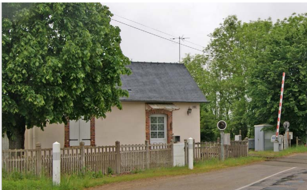
UP00-e Maison de garde barrière (Grez-en-Bouère)
