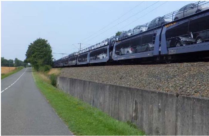
UP08-40-XXX la surélévation de la voie ferrée dans un paysage assez horizontale accentue la visibilité de l'infrastructure (Brée – 2015)
