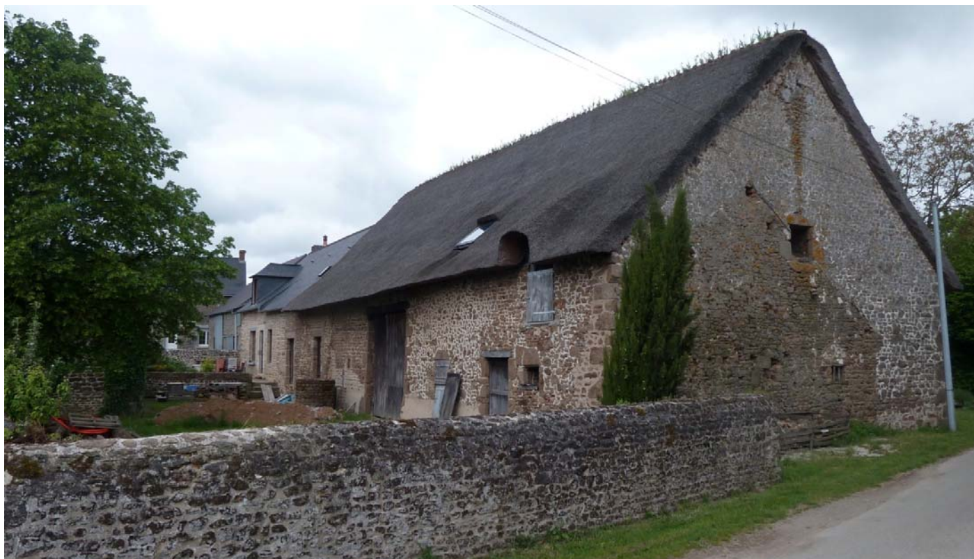
UP8-20-32bis Chaumière en longère avec des murs en moellons de granite (Courcité)
