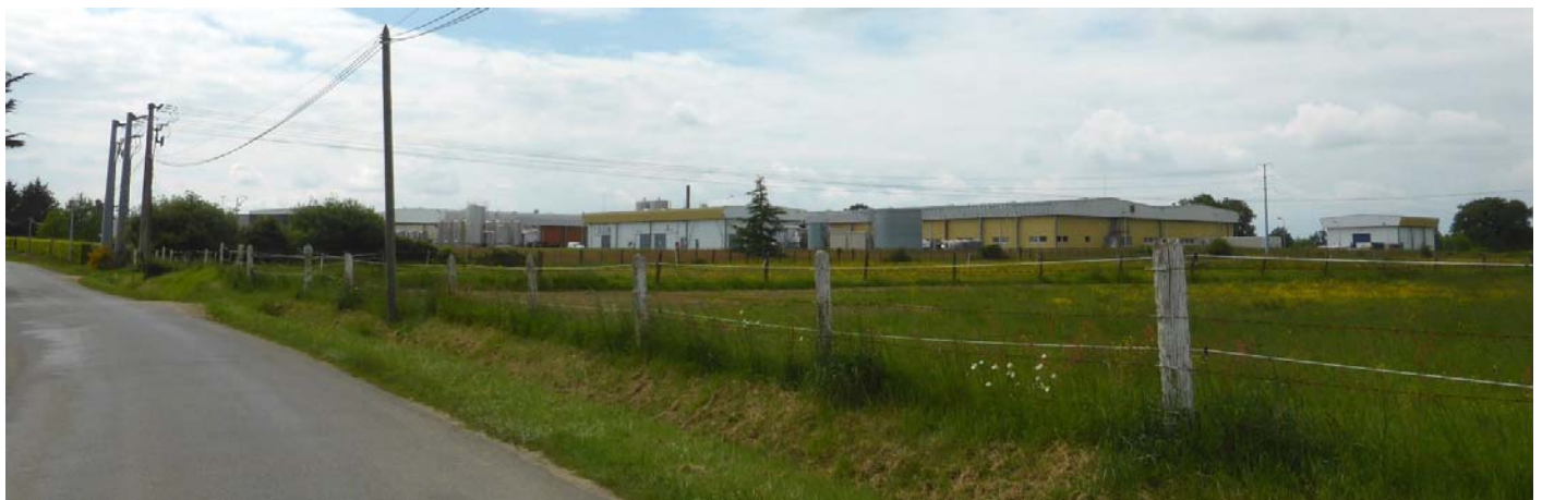
UP07-40-XXX – Le développement des zones d'activités contribue à dessiner les paysages des franges de la partie nord de la ville (Meslay-du-Maine – 2015)
