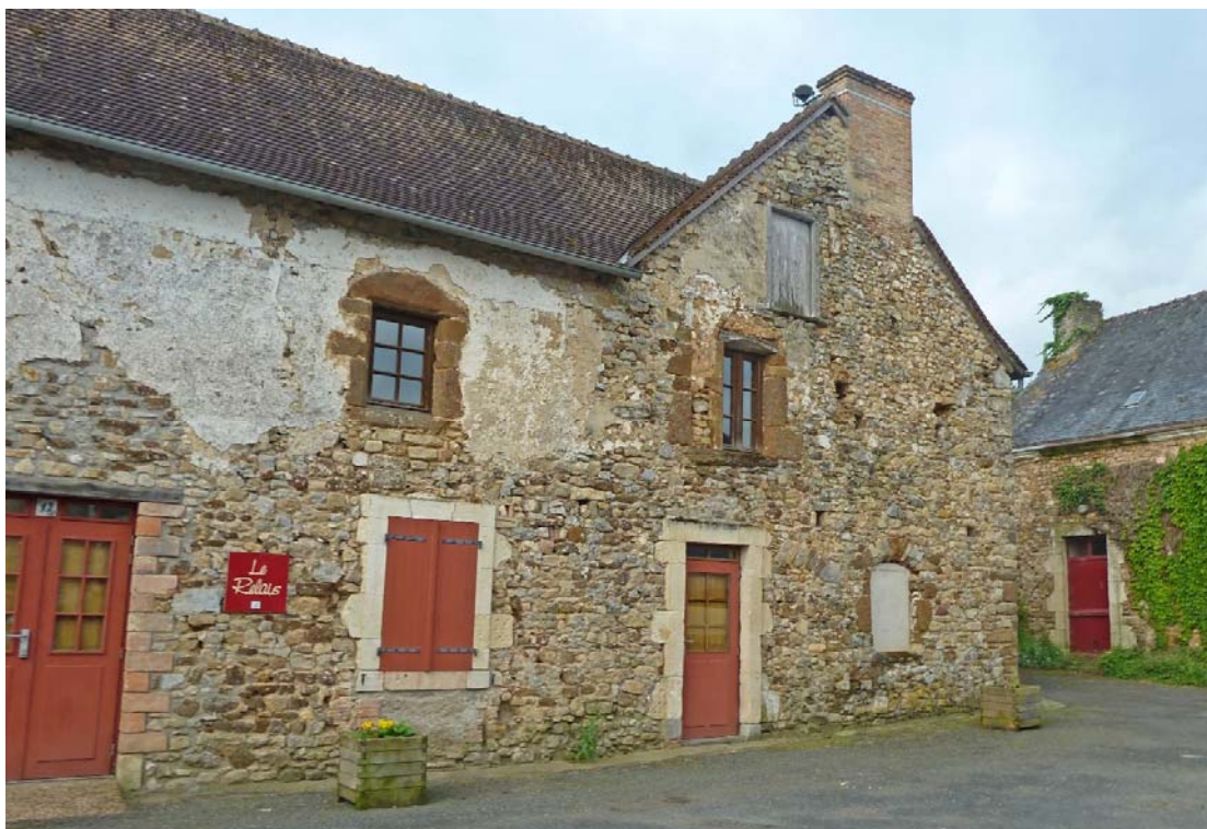
UP7-20-08-Une architecture qui rappelle la champagne sarthoise voisine : grès roussard et calcaire jaune en encadrement de fenêtre et tuile plate (Poillé-sur-Vègre)
