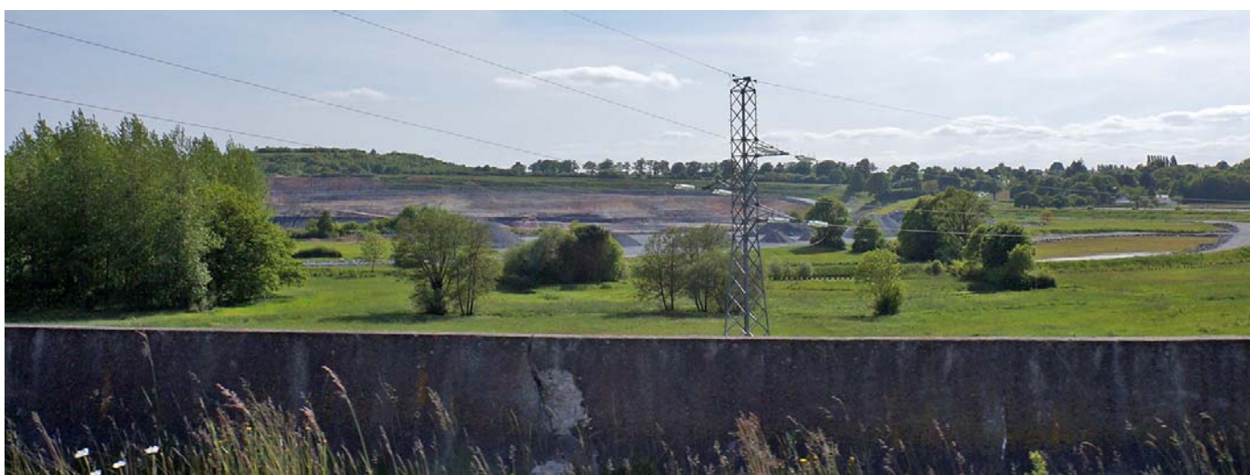
UP05-20-06 Exploitation des calcaires carbonifères, calcaires à chaux, pour la cimenterie du groupe Lafarge (Saint-Pierre-La-Cour)
