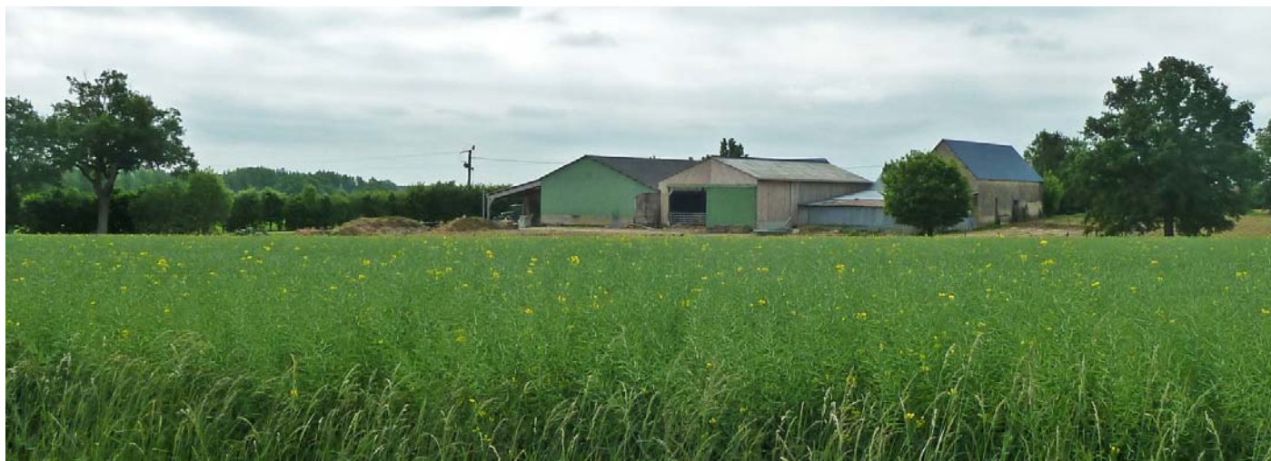
UP7-20-26 Un bâti d'exploitation qui reste dans la volumétrie, les couleurs et le type d'implantation du bâti ancien tout en jouant avec la végétation (Saint-Denis-du-Maine)
