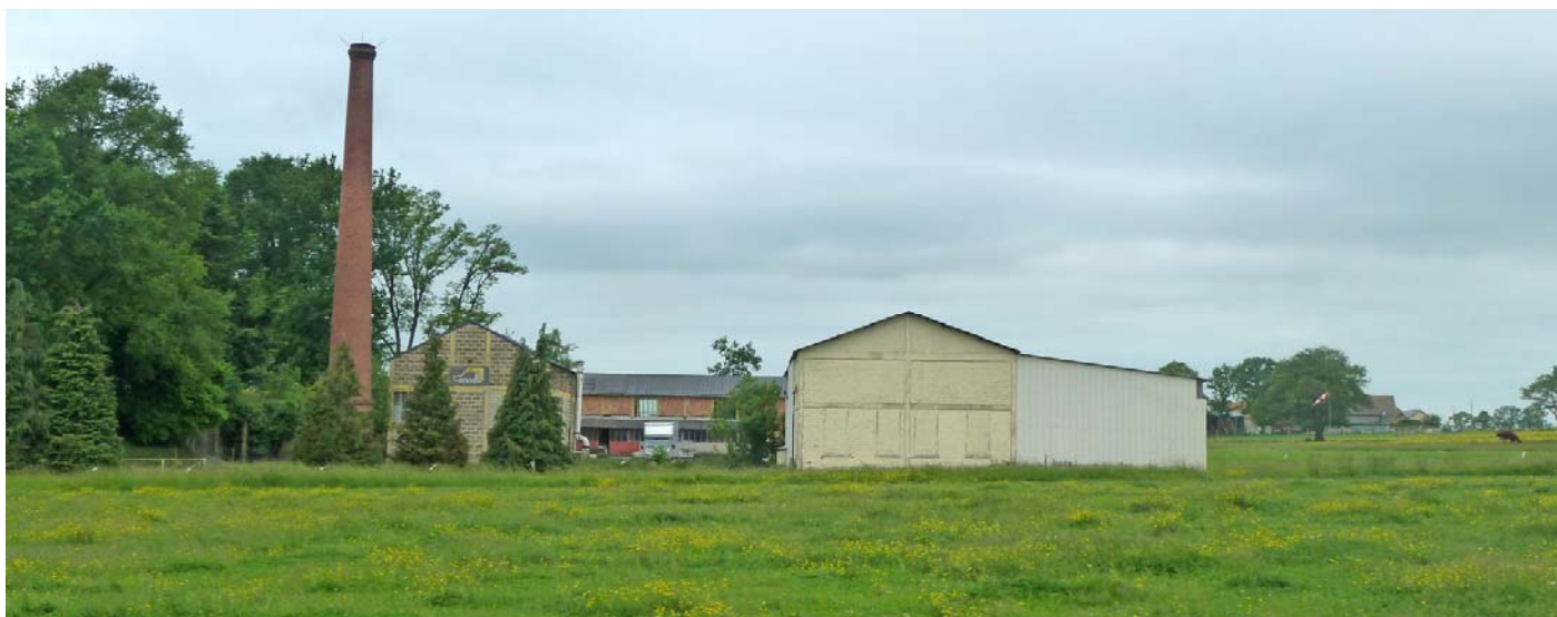
UP05-20-07 architecture industrielle caractéristique des briqueteries (La-Bazouge-de-Chemeré)
