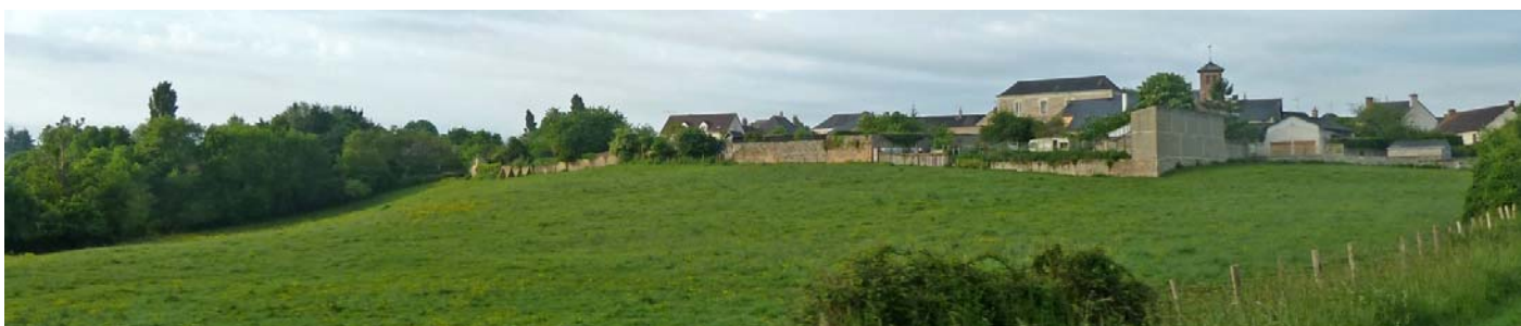
UP7-20-24A Des registres de murs et de clos qui composent des limites nettes autour du bâti et des bourgs (Bouessay)
