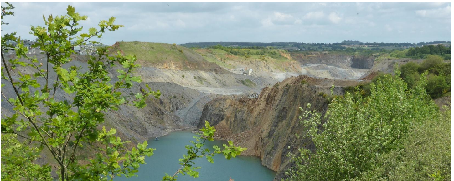
UP07-40-XXX – La constitution de merlon et la préservation des haies autour du site d'exploitation vise à réduire l'impact paysager de proximité de l'imposante carrière (Saint-denis-d'Orques – 2015)
