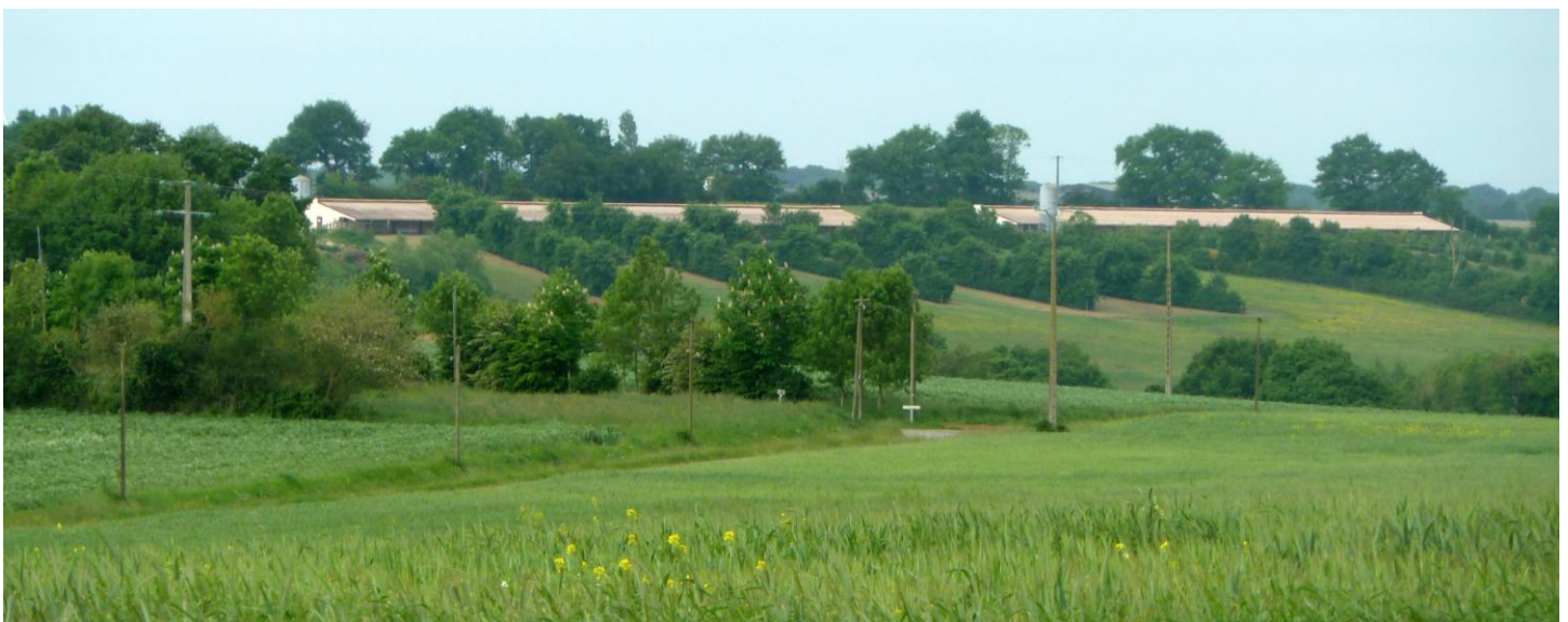
UP7-20-27 Un bâti agricole d'élevage qui s'intègre dans la trame arborée liée au cahier des charges de labellisation (Saint-Pierre-sur-Erve)
