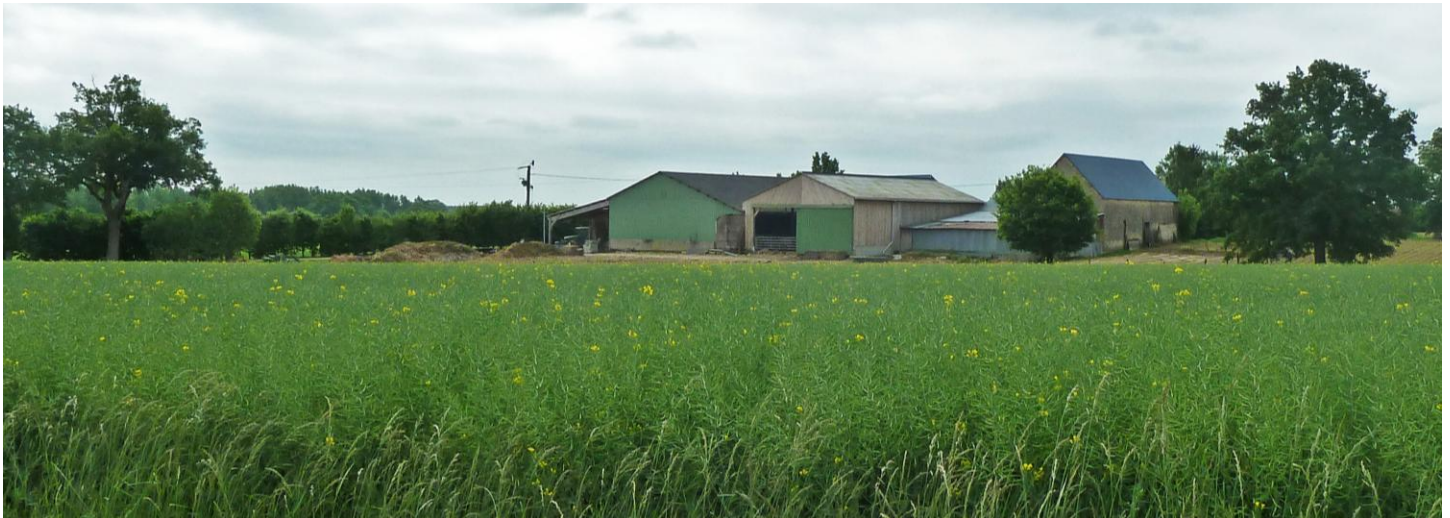
UP7-20-26 Un bâti d'exploitation qui reste dans la volumétrie, les couleurs et le type d'implantation du bâti ancien tout en jouant avec la végétation (Saint-Denis-du-Maine)
