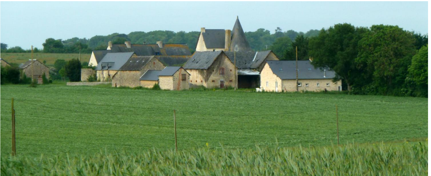
UP7-20-21 D'anciennes fermes avec un logis imposant et des dépendances massives qui témoignent de la richesse de ce terroir agricole (Saint-Pierre-sur-Erve)
