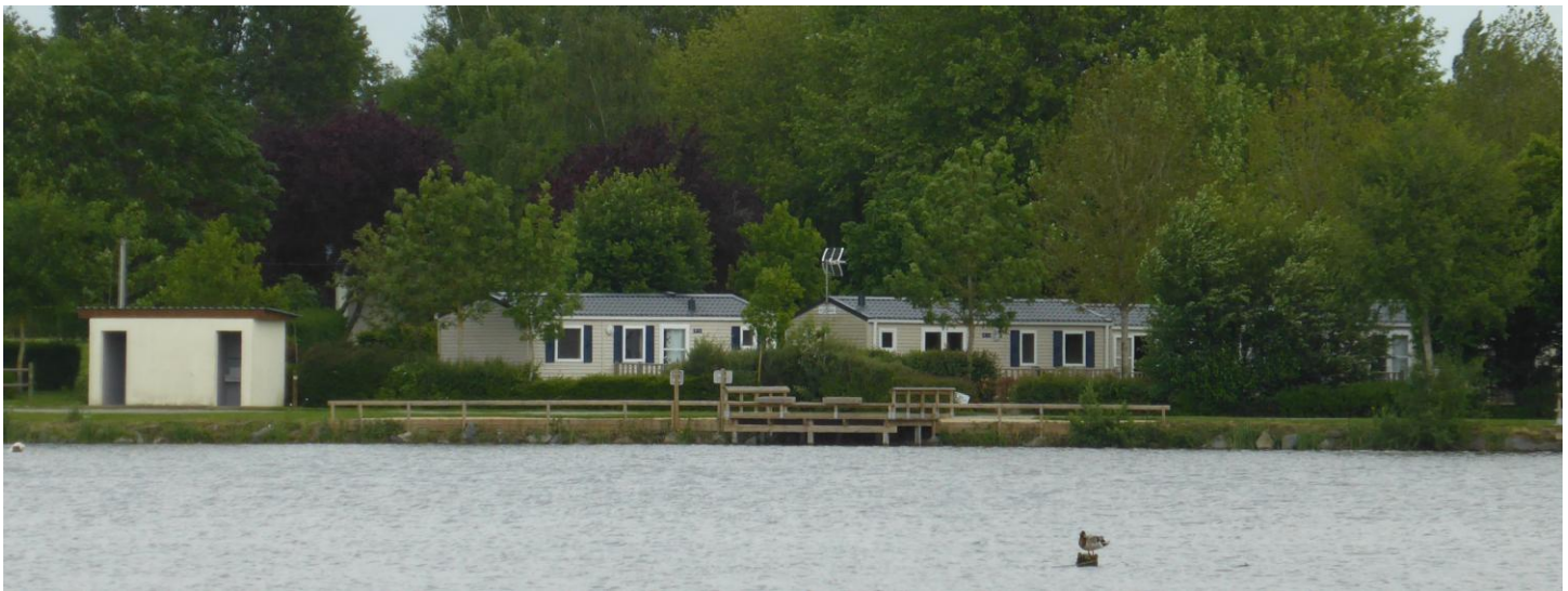
UP07-40-XXX – Un site d'hébergement de plein air s'est installé aux abords du plan d'eau de Buru (Saint-Denis-du-Maine – 2015)
