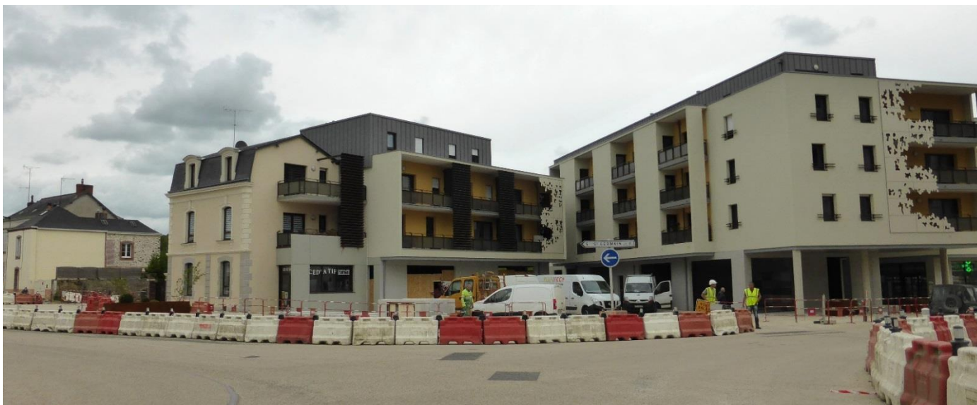
UP06-40-XXX A Changé, les opérations destinées à augmenter les capacités de logements contribuent à inscrire des nouveaux immeubles d'habitat collectif dans le centre ancien (Changé - 2015)
