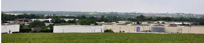
3 La force et l'impact des zones industrielles cernant l'agglomération lavalloise, formant un premier plan qui masque la silhouette urbaine (Bonchamp-lès-Laval),
