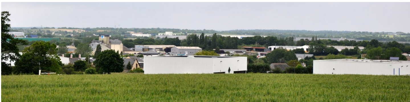
UP06-30-10 Des zones industrielles marquantes malgré l'alternance entre végétation et bâtiments – Zone d'activités de Bonchamp (les Bouessay – Bonchamp-Lès-Laval)
