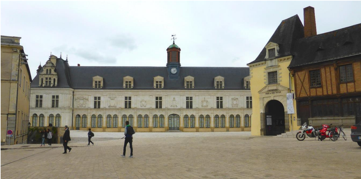
UP06-40-XXX Les aménagements récents de l'espace public aux abords du château favorisent la mise en valeur du monument (Laval - 2015)
