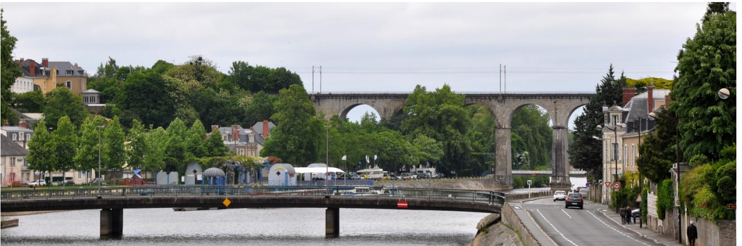
UP06-30-05 Viaduc ferroviaire marquant le changement de séquence paysagère, porte nord de la Mayenne urbaine (Laval)
