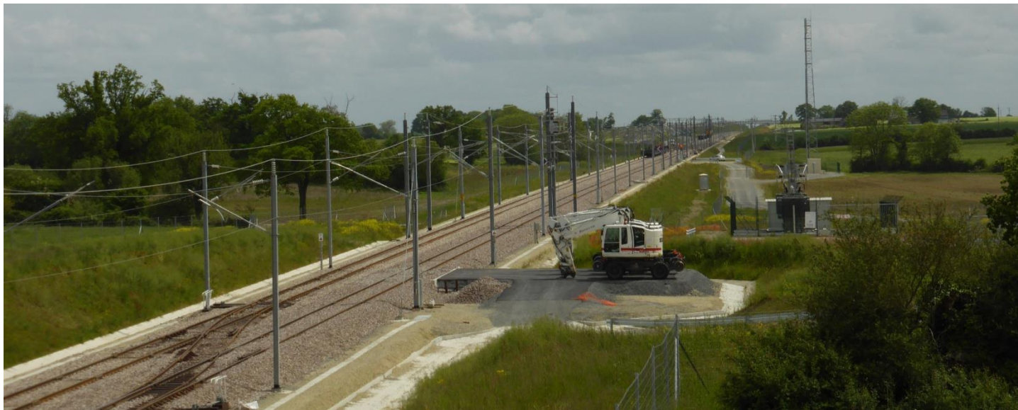
UP05-40- XXX L'aménagement de la LGV accentue la présence des infrastructures dans le paysage de l'unité (Louvigné - 2015)
