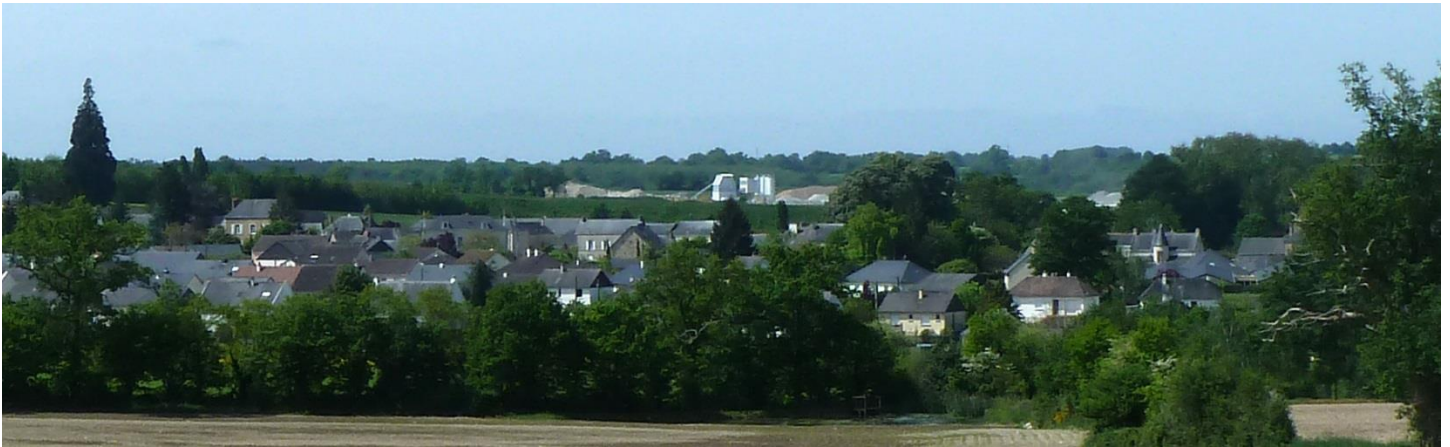
UP05-20-04 Horizon boisé ponctué par les concasseurs de l'exploitation des rhyolites, roche volcanique recherchée pour les granulats et empierrement (Entrammes)
