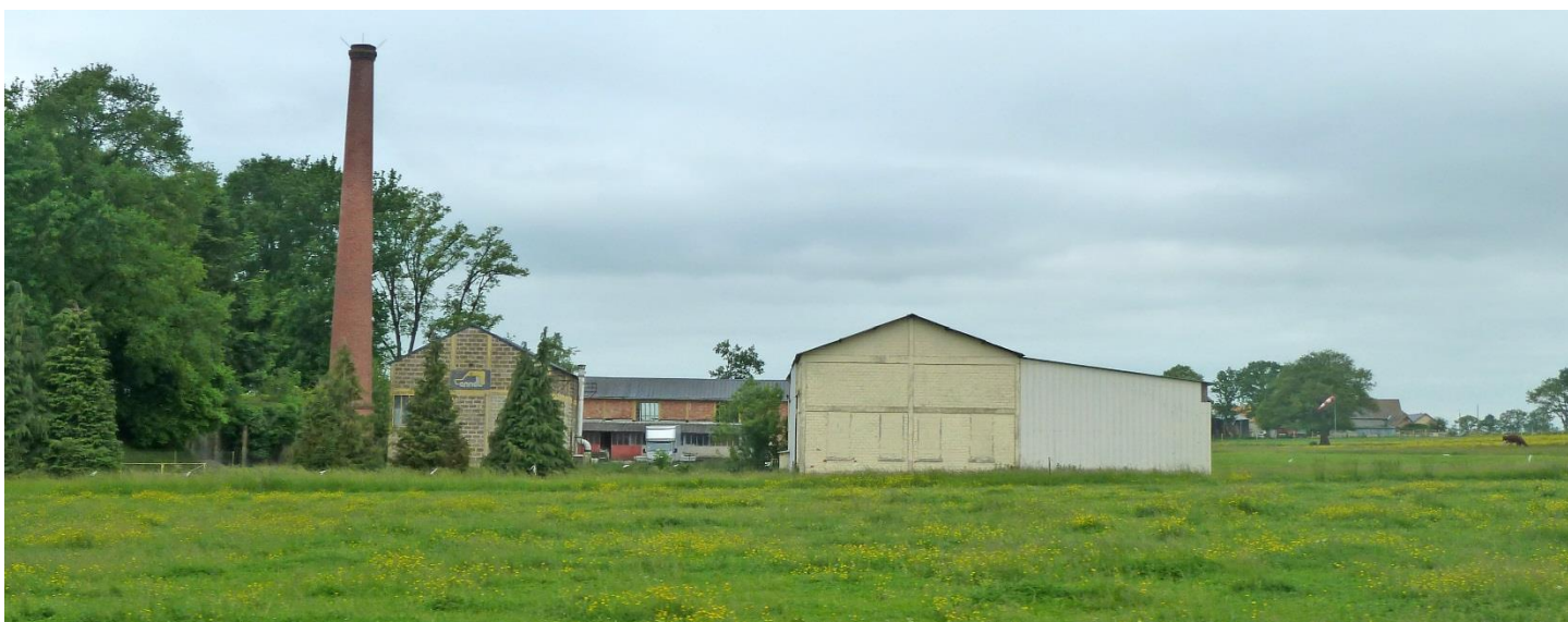
UP05-20-07 architecture industrielle caractéristique des briqueteries (La-Bazouge-de-Chemeré)
