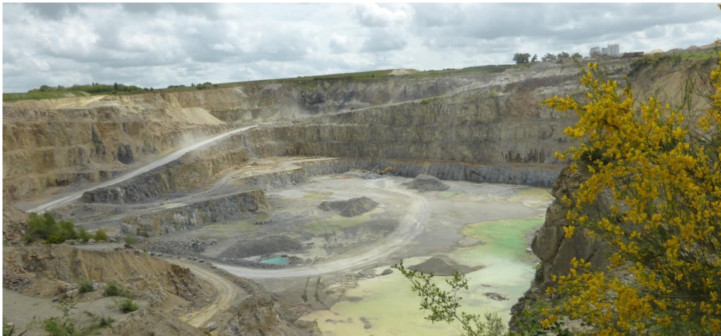
UP05-40-XXX A Entrammes, une carrière en exploitation, peu perceptible depuis les espaces environnants (Entrammes – 2015)
