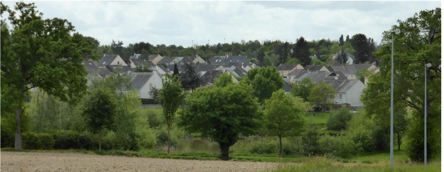
UP05-50-XXX Le maintien du linéaire bocager sur les franges urbaines permet d'accompagner les extensions urbaines (Entrammes)
