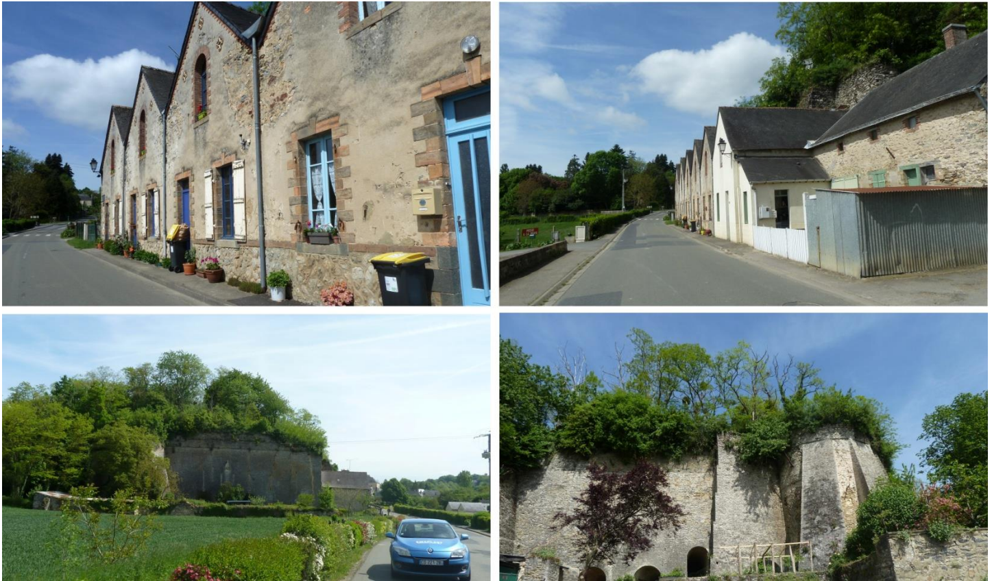
UP05-20-02 Four à Chaux et logements associés de Parnay-sur-Roc
