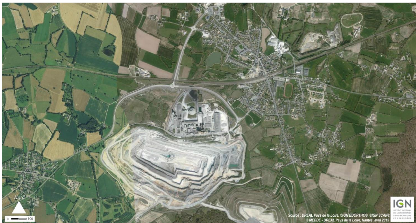
UP05-40-XXX La carrière de Saint-Pierre-la-Cour et la cimenterie occupent une surface de 30 hectares (2010)
