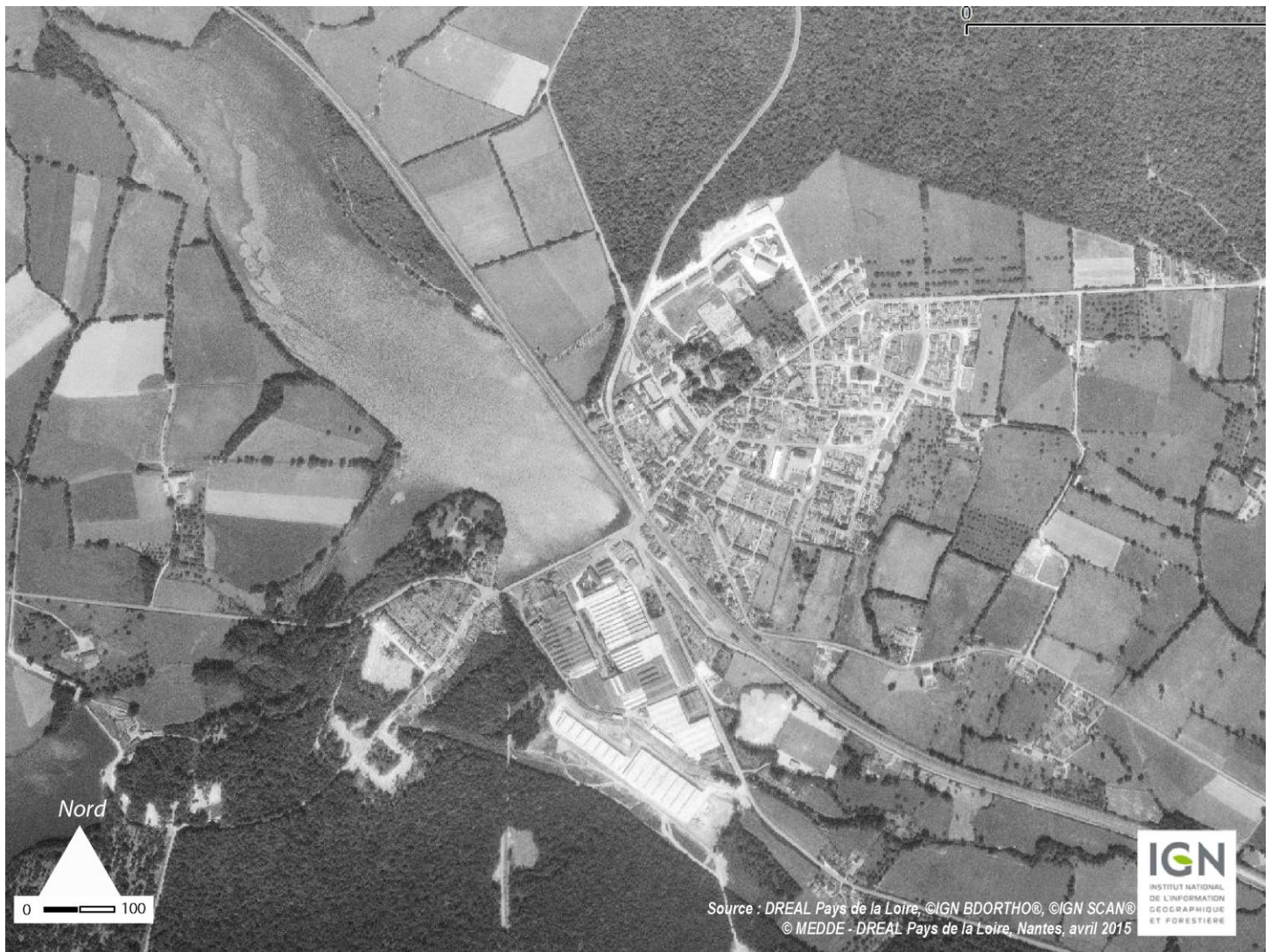
UP05-40-XXX L'urbanisation s'oriente progressivement vers le nord de Port-Brillet (BD ORTHO Historique 1969)
