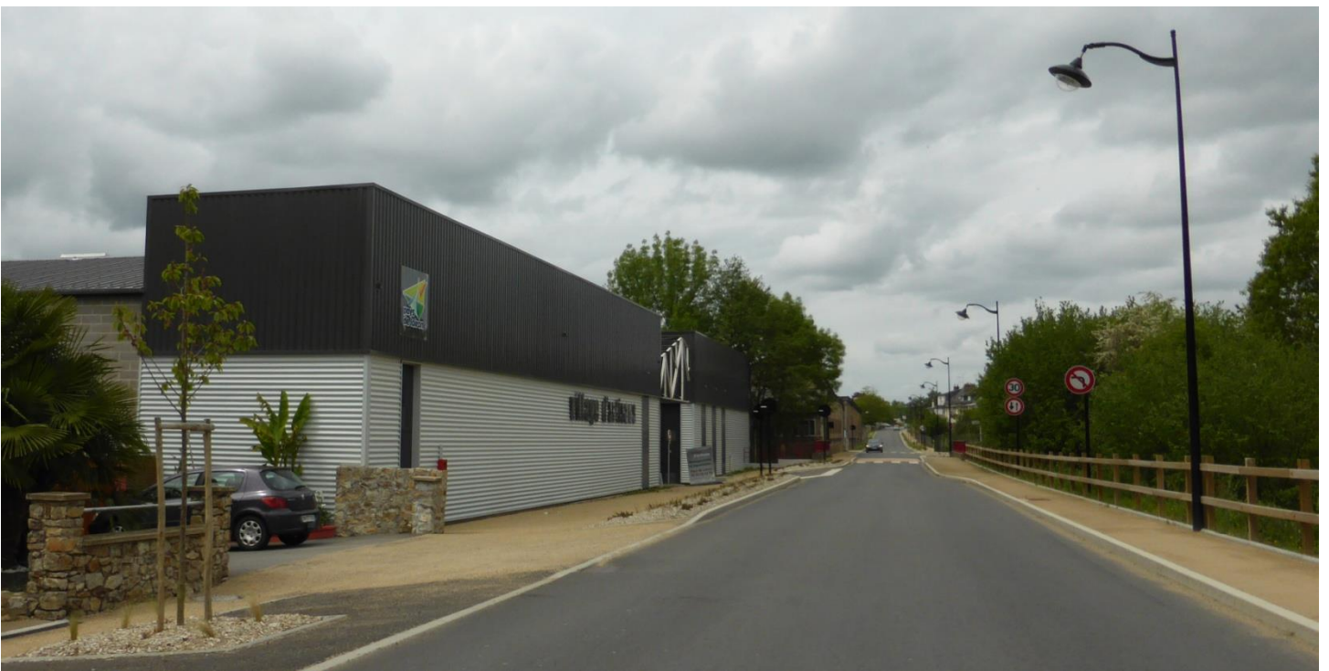
UP05-40-XXX Des interventions récentes sur l'espace public et la requalification des anciens bâtiments industriels visent à requalifier le site (Port-Brillet - 2015)
