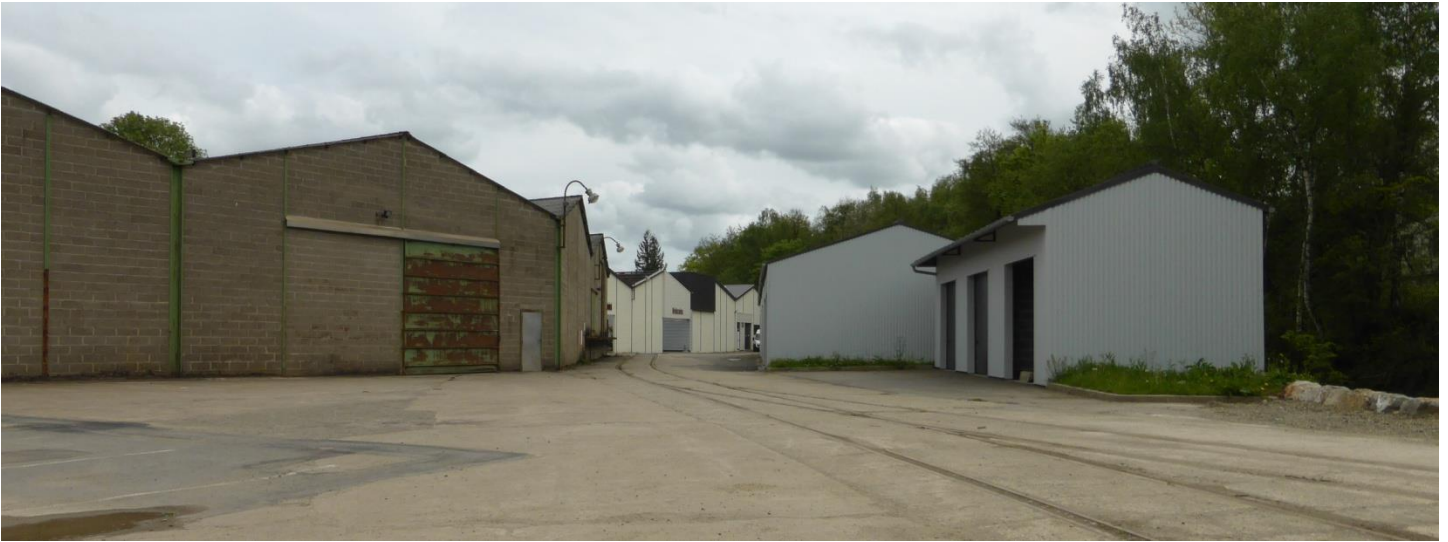
UP05-40-XXX Des opérations de réhabilitation et de requalification de l'existant sont engagées (Port-Brillet - 2015)
