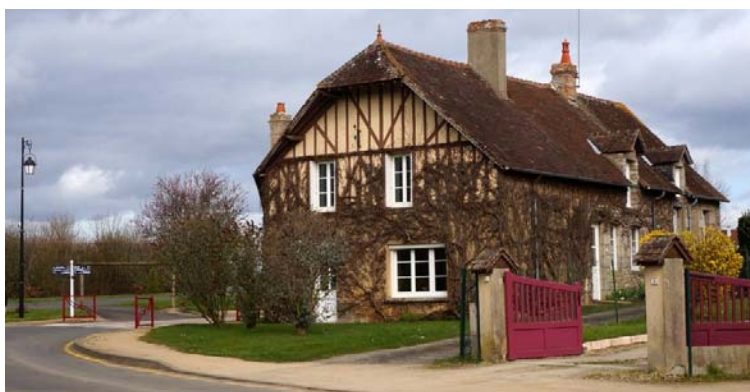
UP4-20-18 Un bâti à colombage qui n'est pas sans rappeler la Normandie (Lignières-la-Carelle)
