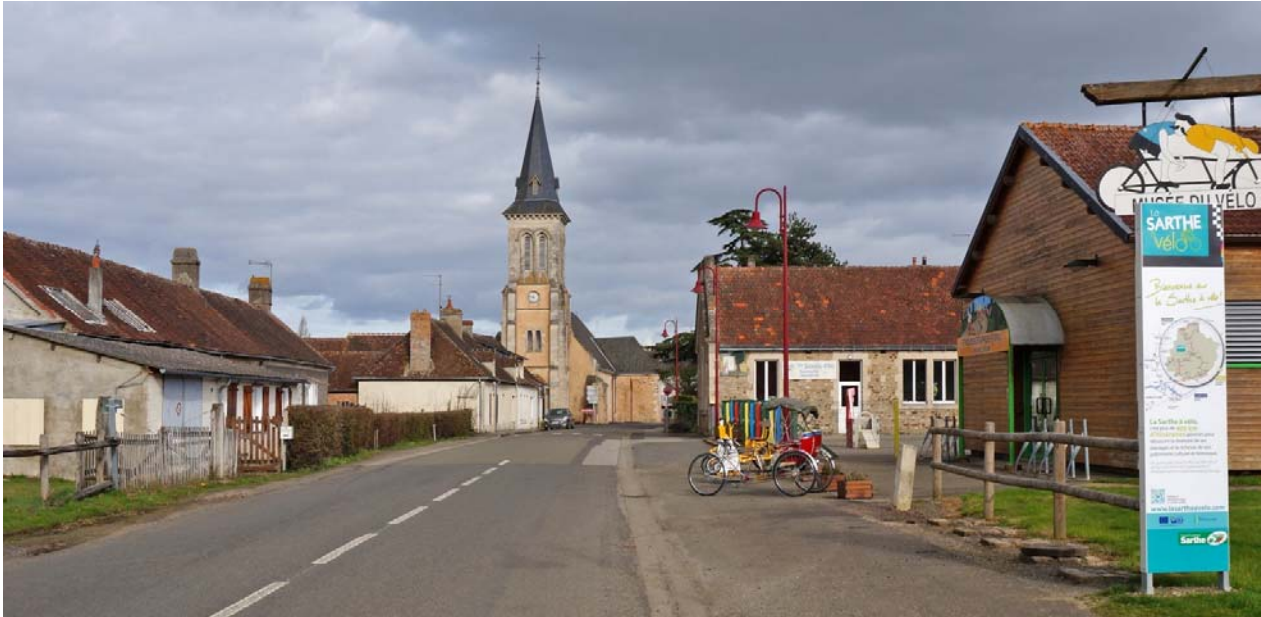
UP4-20-21 Des villages rue qui s'étirent sur la D16 (La Fresnaye-sur-Chédouet)
