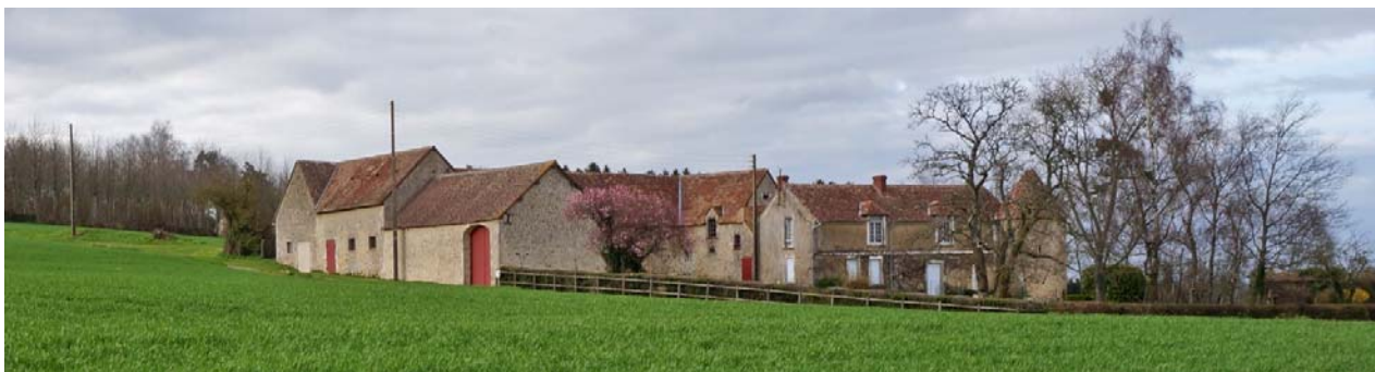
UP4-20-17 Un bâti rural massif qui s'organise contre la pente autour d'une cour exposée sud (Aillières-Beauvoir)
