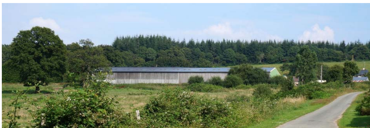
03-20-IM15 les nouveaux bâtiments d'exploitation qui prolongent et masquent parfois les anciens corps de ferme (corniche de Pail)
