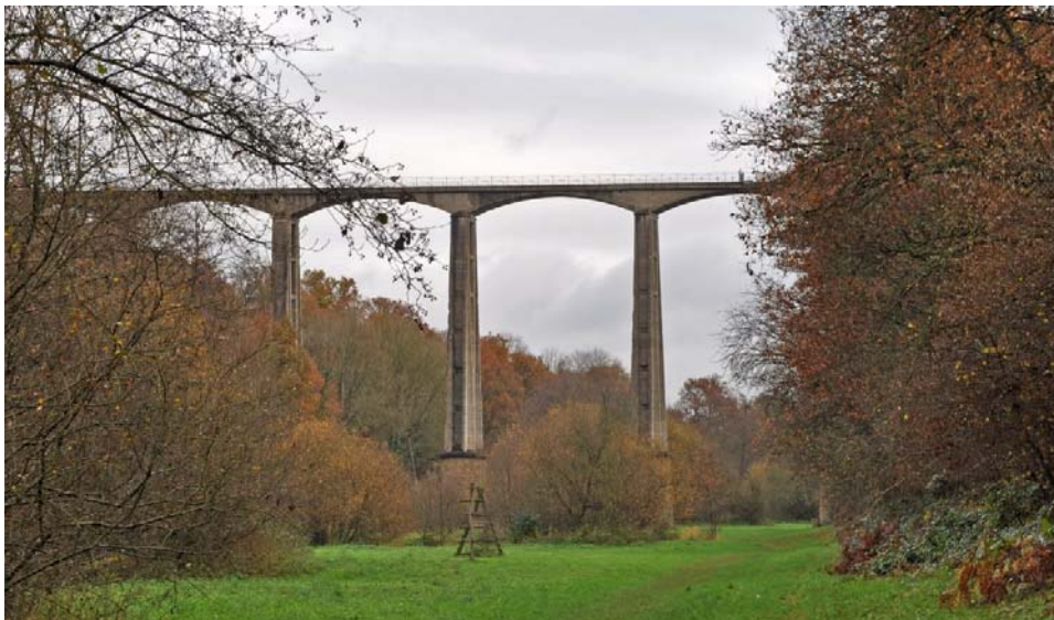
03-40-IM03 Le viaduc ferroviaire sur la Vaudelles de Saint-Georges-le-Gaultier, un point de départ patrimonial pour la pratique du saut à l'élastique.
