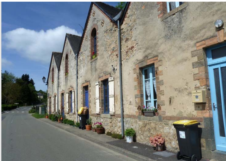
UP00-c Maison ouvrière (Parné-sur-Roc)
