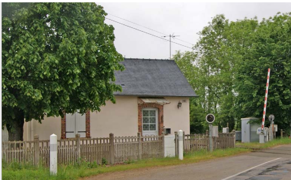
UP00-e Maison de garde barrière (Grez-en-Bouère)
