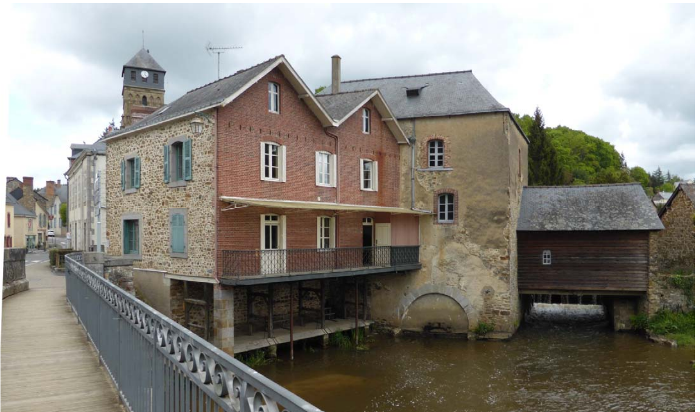
UP01-50- XXX La réhabilitation du patrimoine ancien lié à l'eau participe à la valorisation des centres historiques (Chailland)
