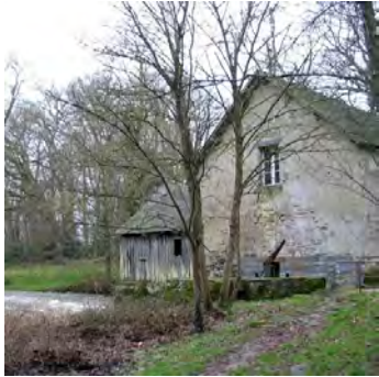
Moulin à eau dans la vallée du Don
