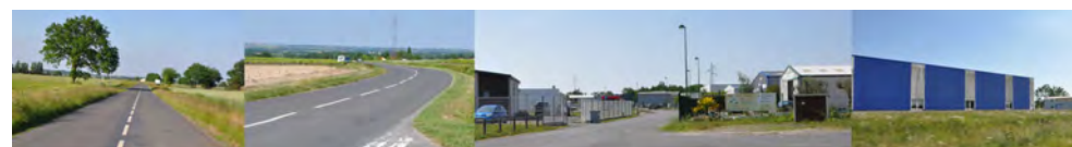
Infrastructures et économie
