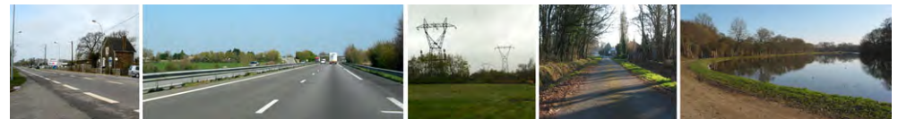
Infrastructures et économie
